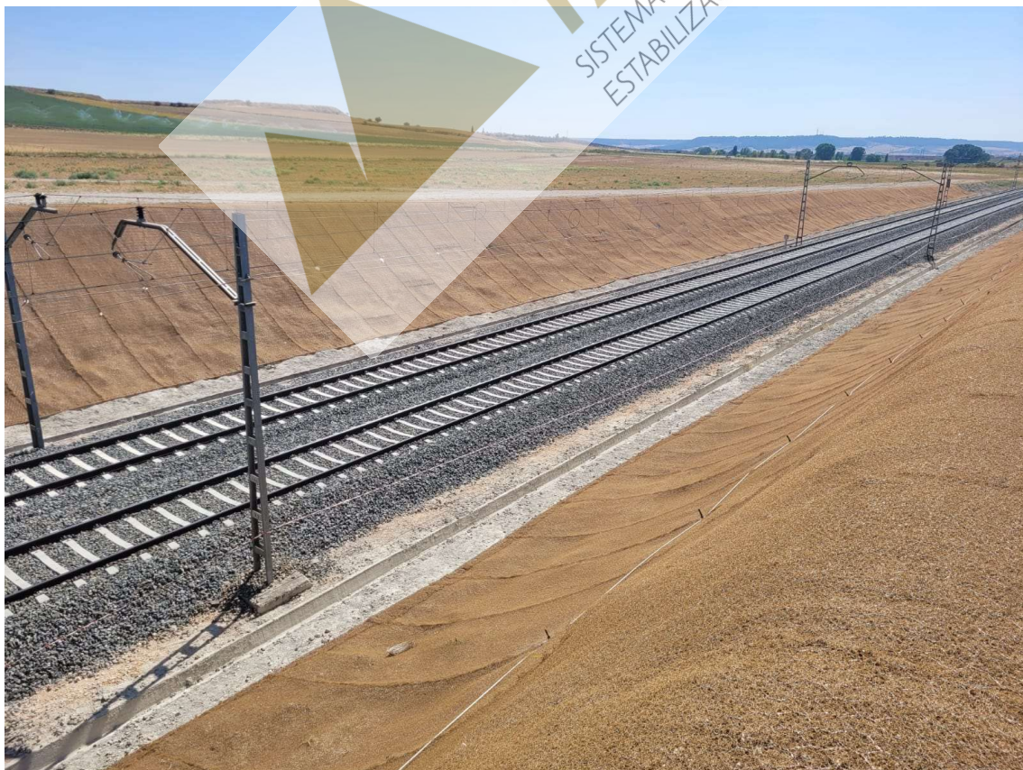
Comparativo de los taludes antes y después de realizar los trabajos.
