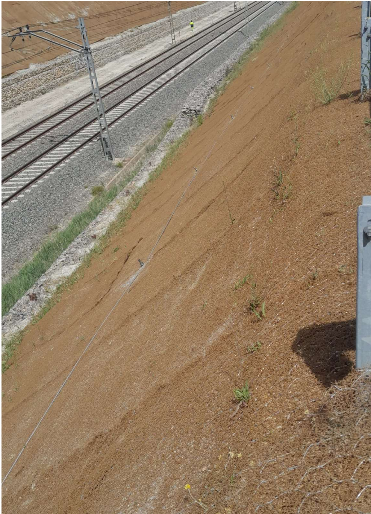
Detalle del crecimiento de vegetación a través de la geomalla.
