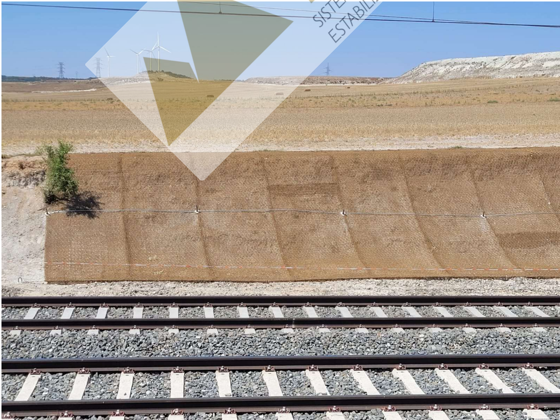
Detalle del correcto ceñido de la geomalla al talud mediante cable de acero horizontal.
