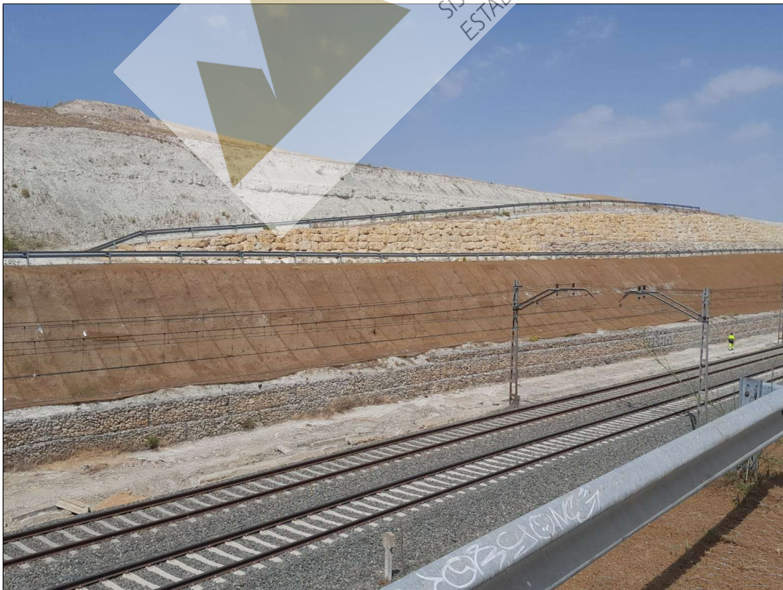
Panorámica de los taludes con geomalla y refuerzo con cable de acero y bulones.
