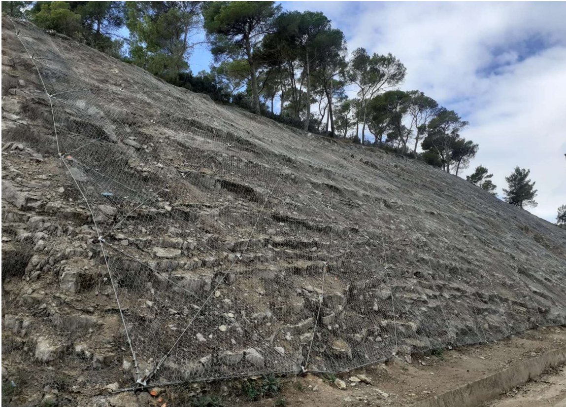
Vista de uno de los taludes después de finalizados los trabajos.
