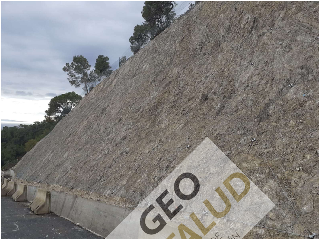
Vista de uno de los taludes después de finalizar los trabajos.
