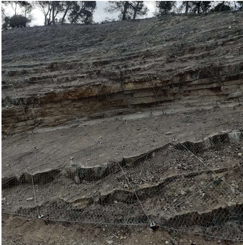
Detalle del adaptado de la malla al talud mediante los bulones.
