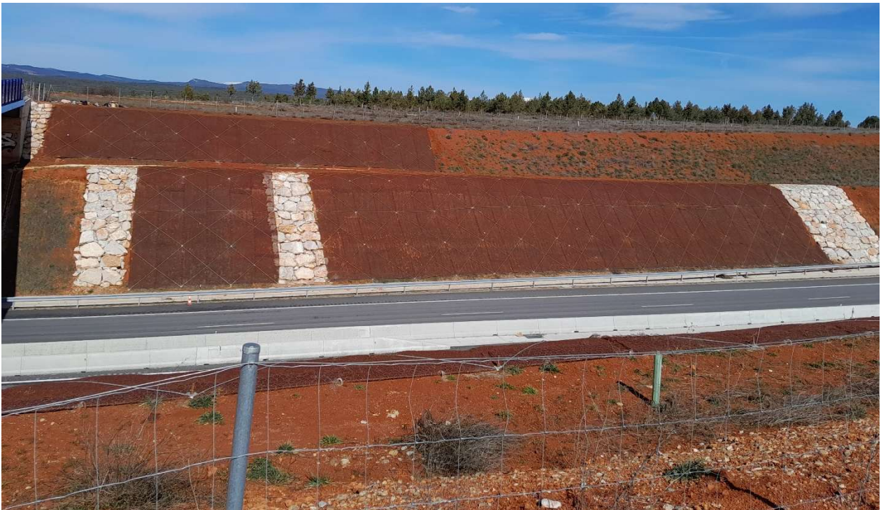
Panorámica de los taludes al finalizar los trabajos.
