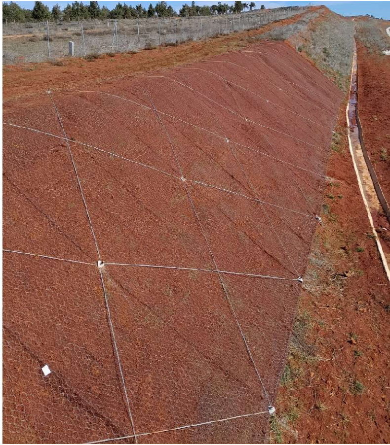
Vista de uno de los taludes totalmente terminado.
