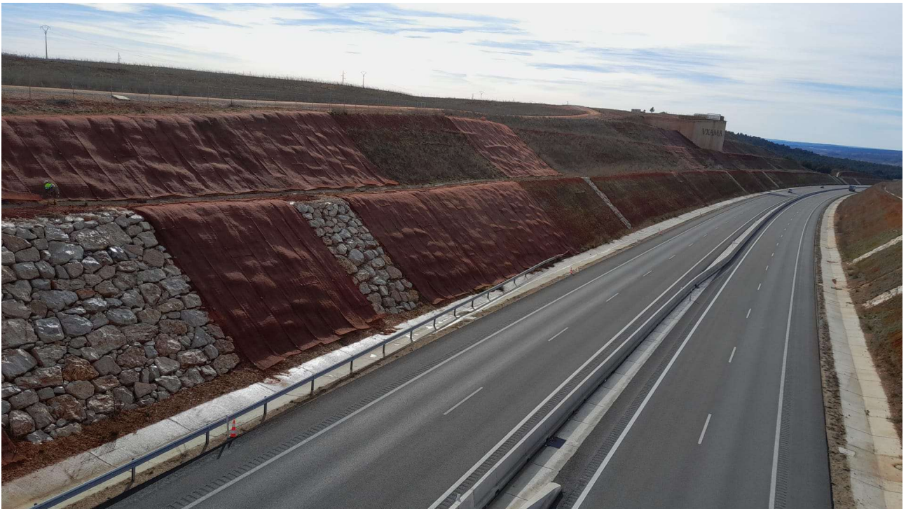
Panorámica de los taludes después de extendida la geomalla.
