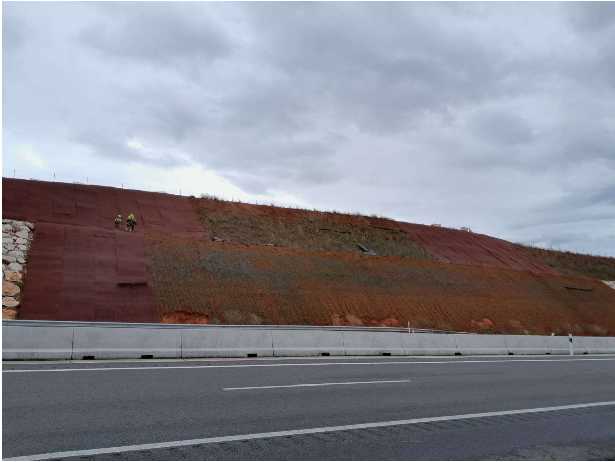
Labores de tendido de geomalla reforzada.
