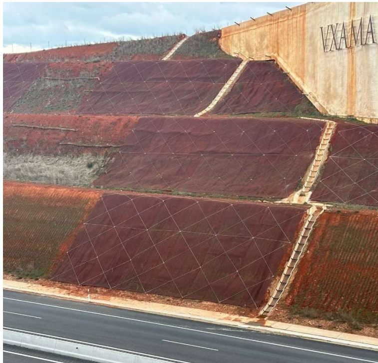
Panorámica de varios taludes al finalizar los trabajos.
