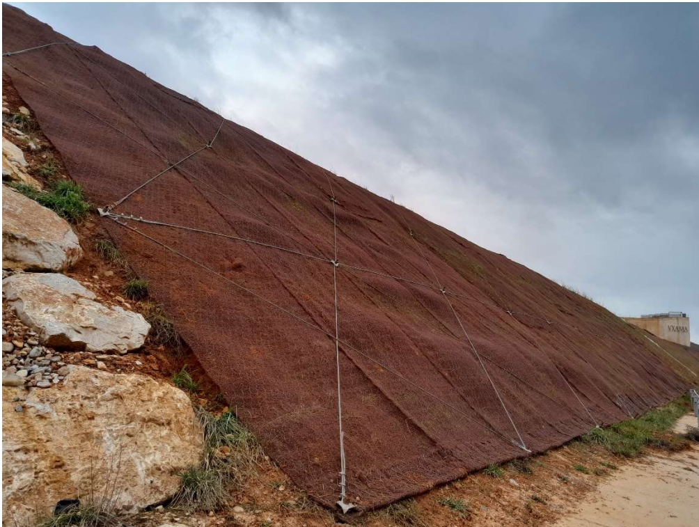
Detalle del refuerzo con cable y bulones uno de los taludes.
