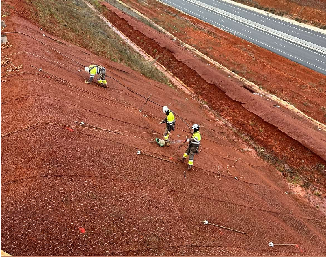
Tareas de cosido de geomalla y perforación.
