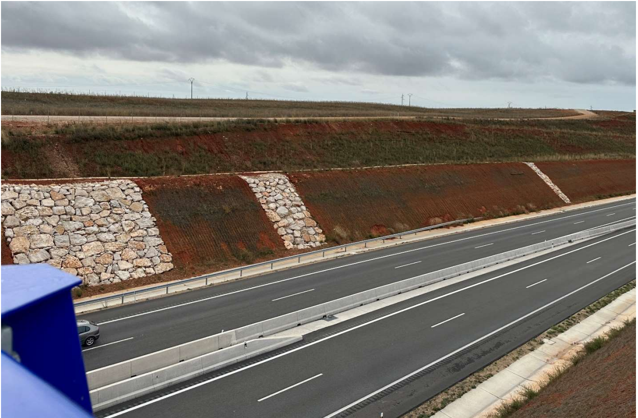
Panorámica de los taludes previo a la realización de los trabajos.
