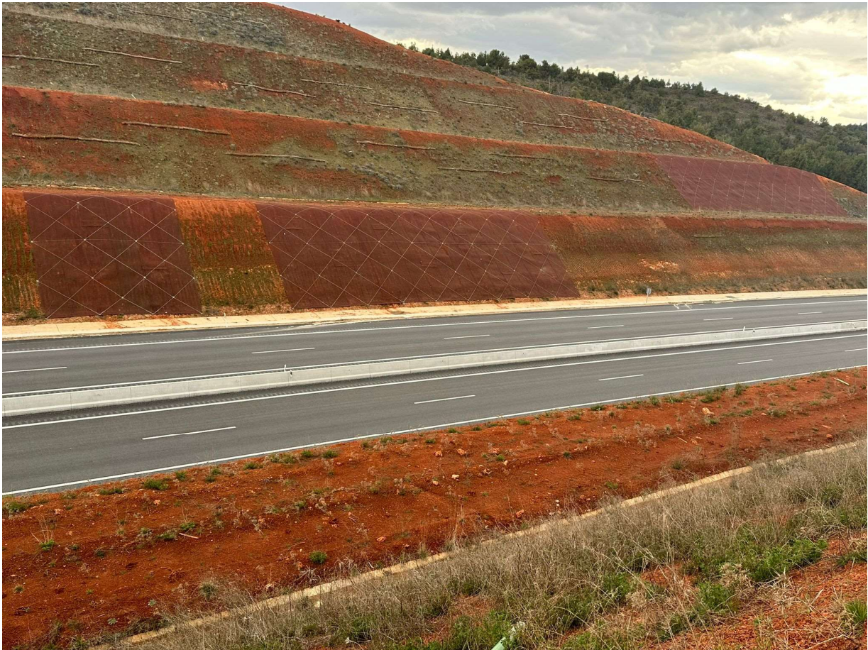
Panorámica de varios taludes al finalizar los trabajos.
