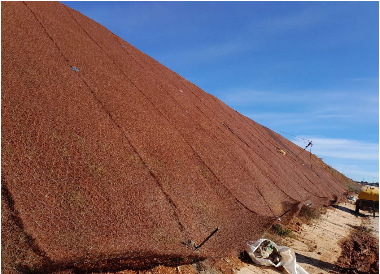
Panorámica de los taludes después de extendida la geomalla.
