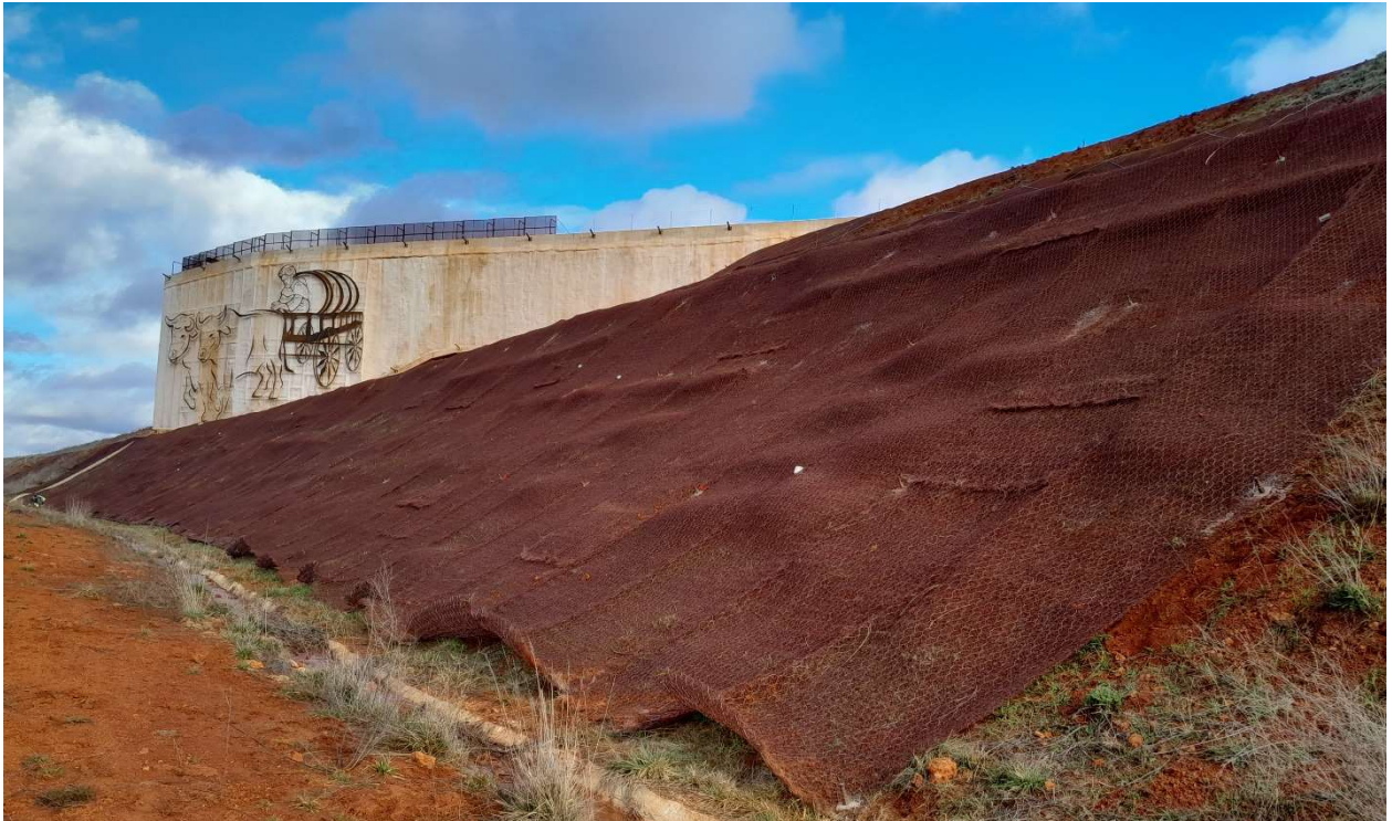
Tareas de tendido de geomalla.
