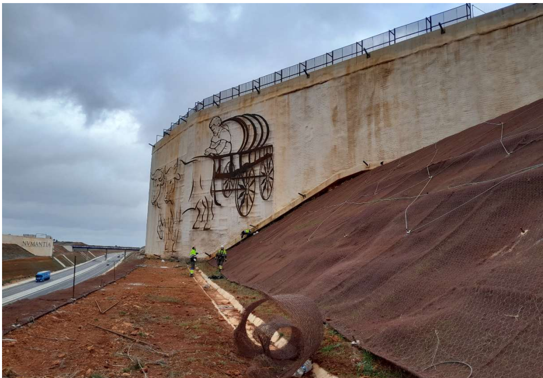
Tareas de tendido de cable de refuerzo en uno de los taludes.
