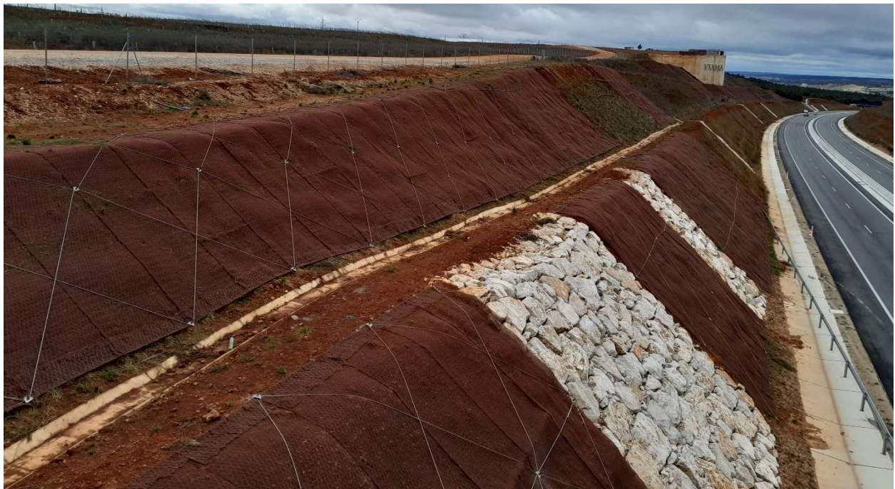
Detalle del crecimiento de vegetación a través de la geomalla.
