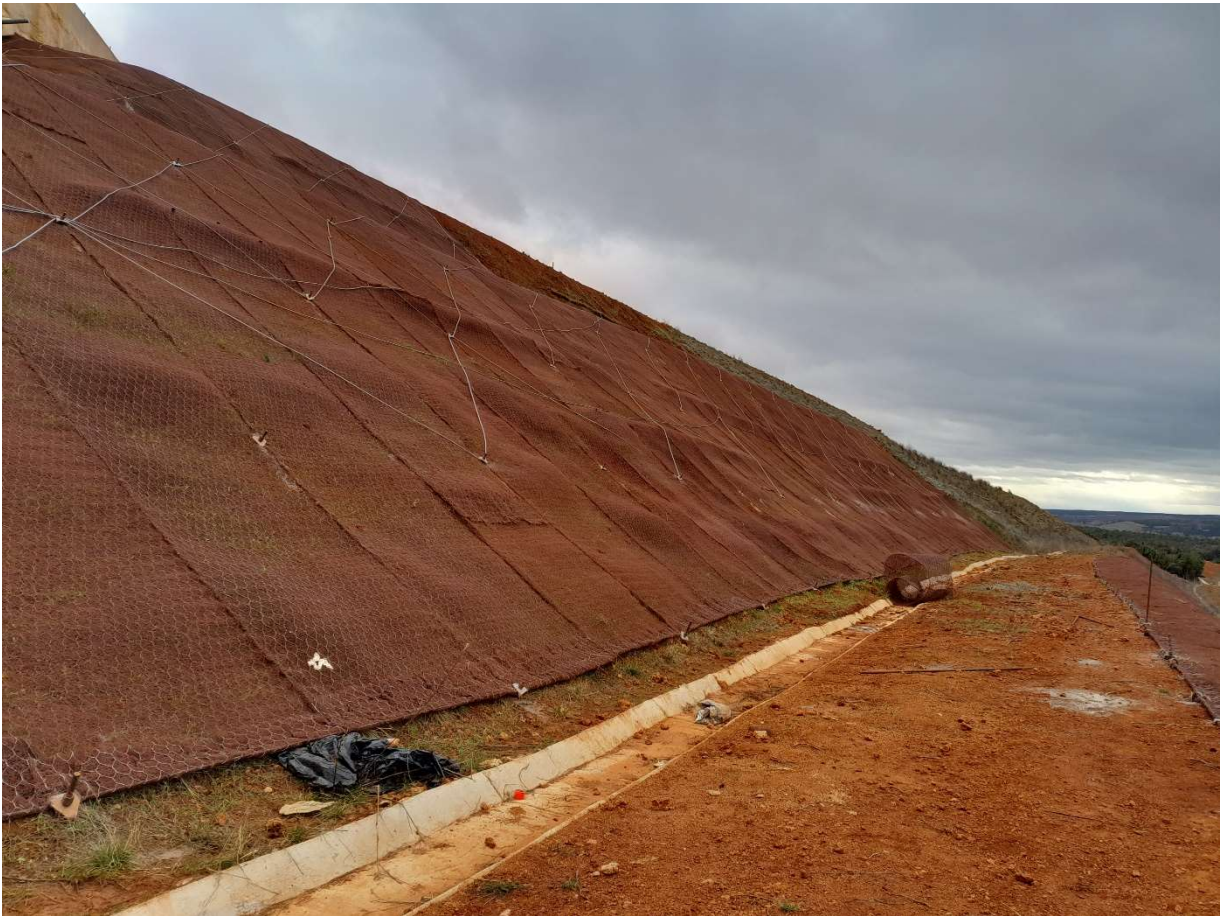
Vista de uno de los taludes durante el tendido de cable.
