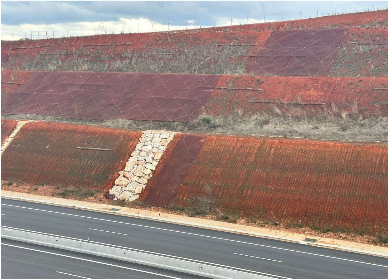
Vista general de algunos taludes al finalizar los trabajos.
