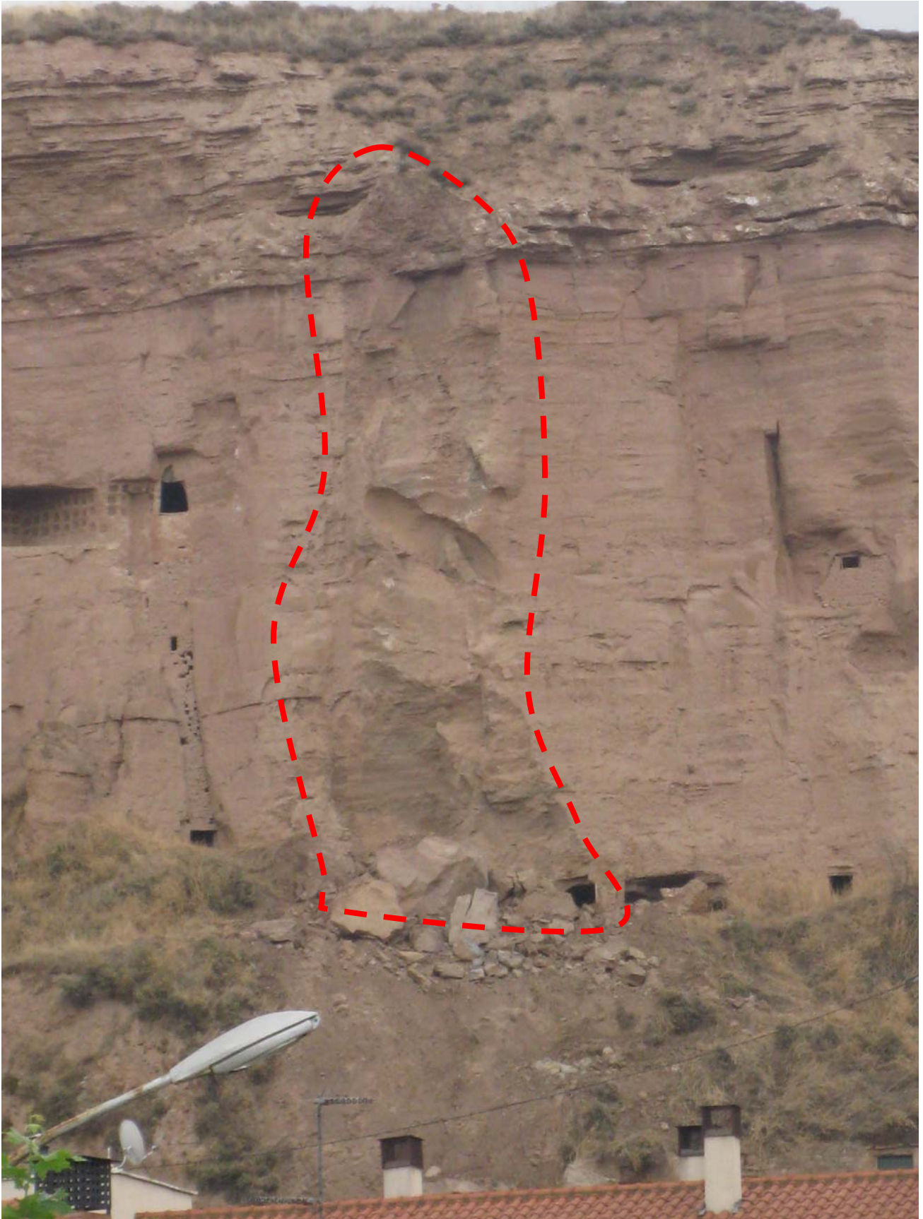
Detalle del desprendimiento. Se aprecia perfectamente la “cicatriz” en la superficie del talud.
