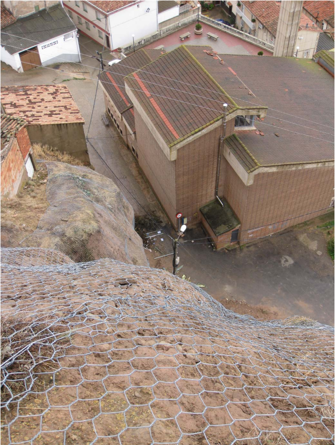
Detalle del talud, visto desde la cabecera del mismo.
