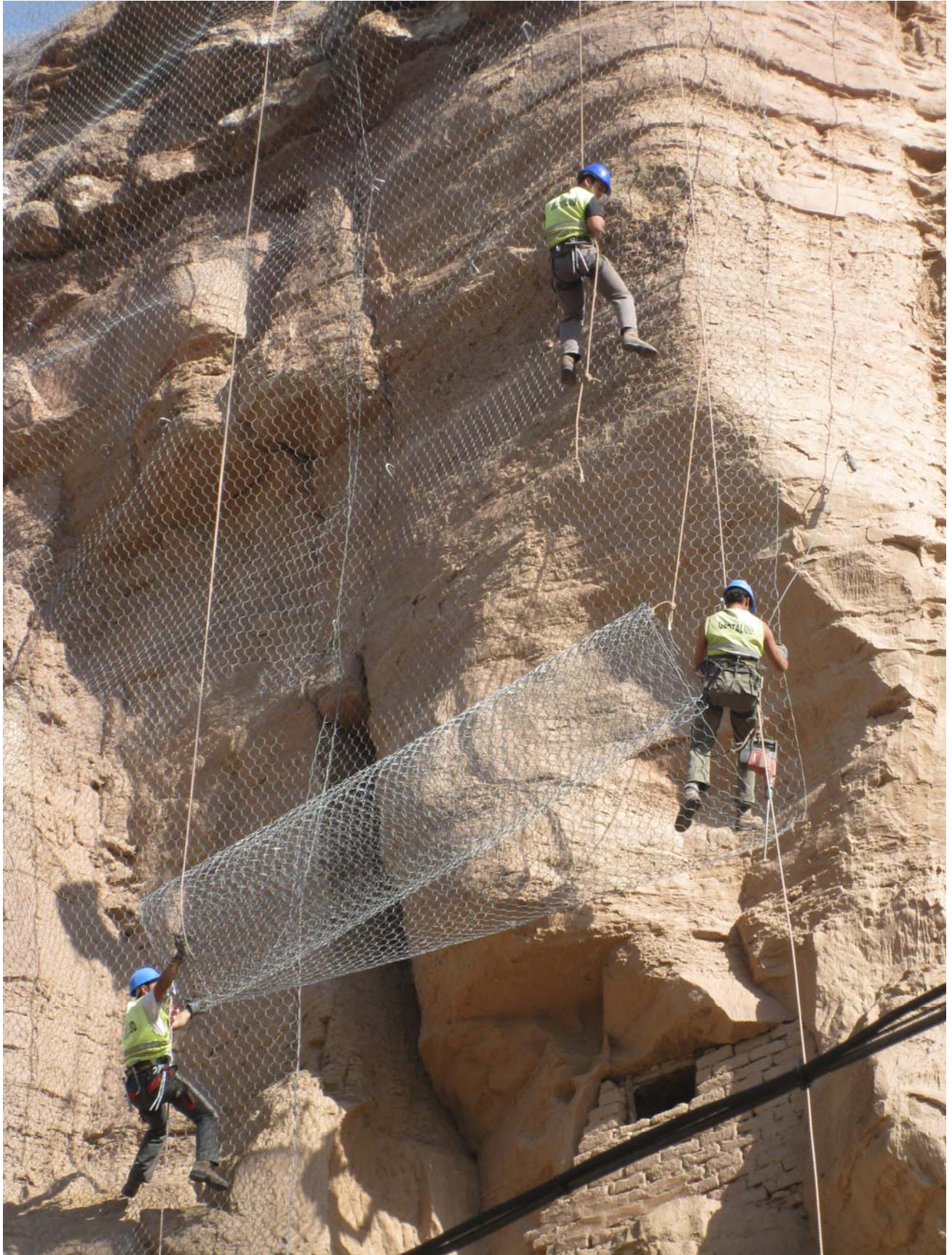
Detalle del trabajo de ceñido de la malla a base de piquetas mediante la utilización de taladros eléctricos.
