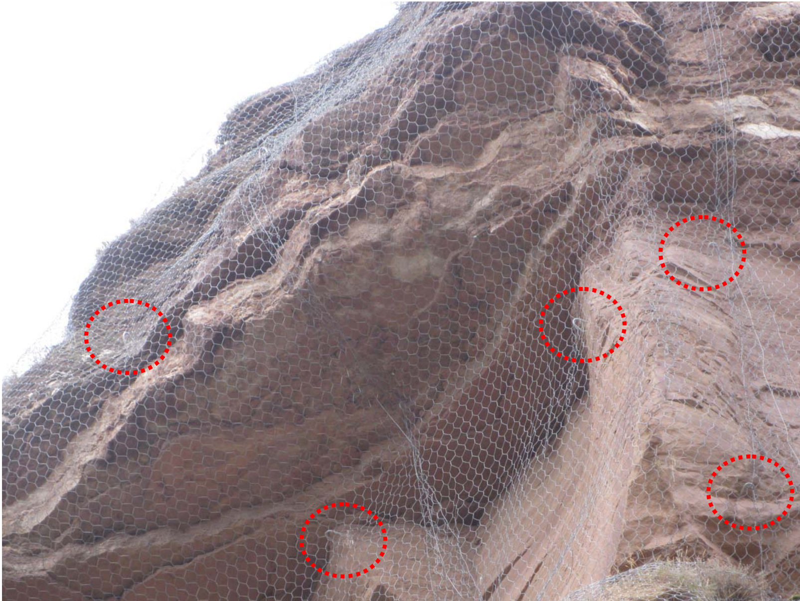
Detalle del ceñido de la malla al terreno, a base de piquetas de acero galvanizado ( L=0,5 m Ø 2mm)
