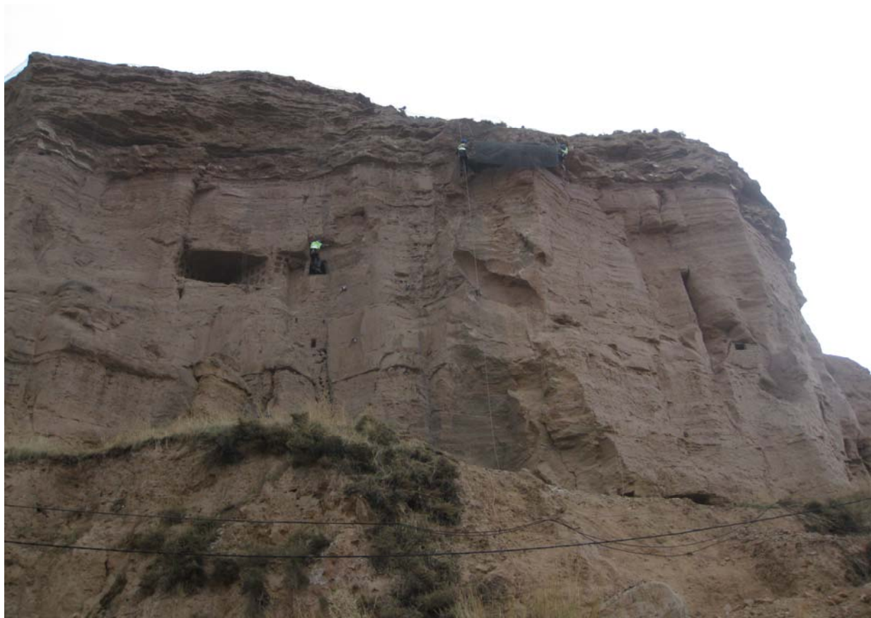
Inicio de los trabajos de extendido de los paños de malla
