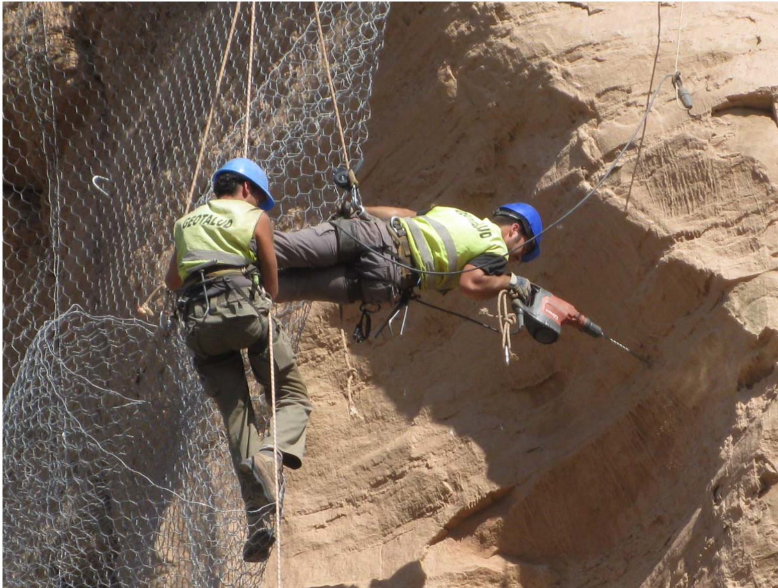
Trabajos de colocación de piquetas de acero ( L= 0,5 m. Ø 12 mm) para ceñimiento de la malla.
