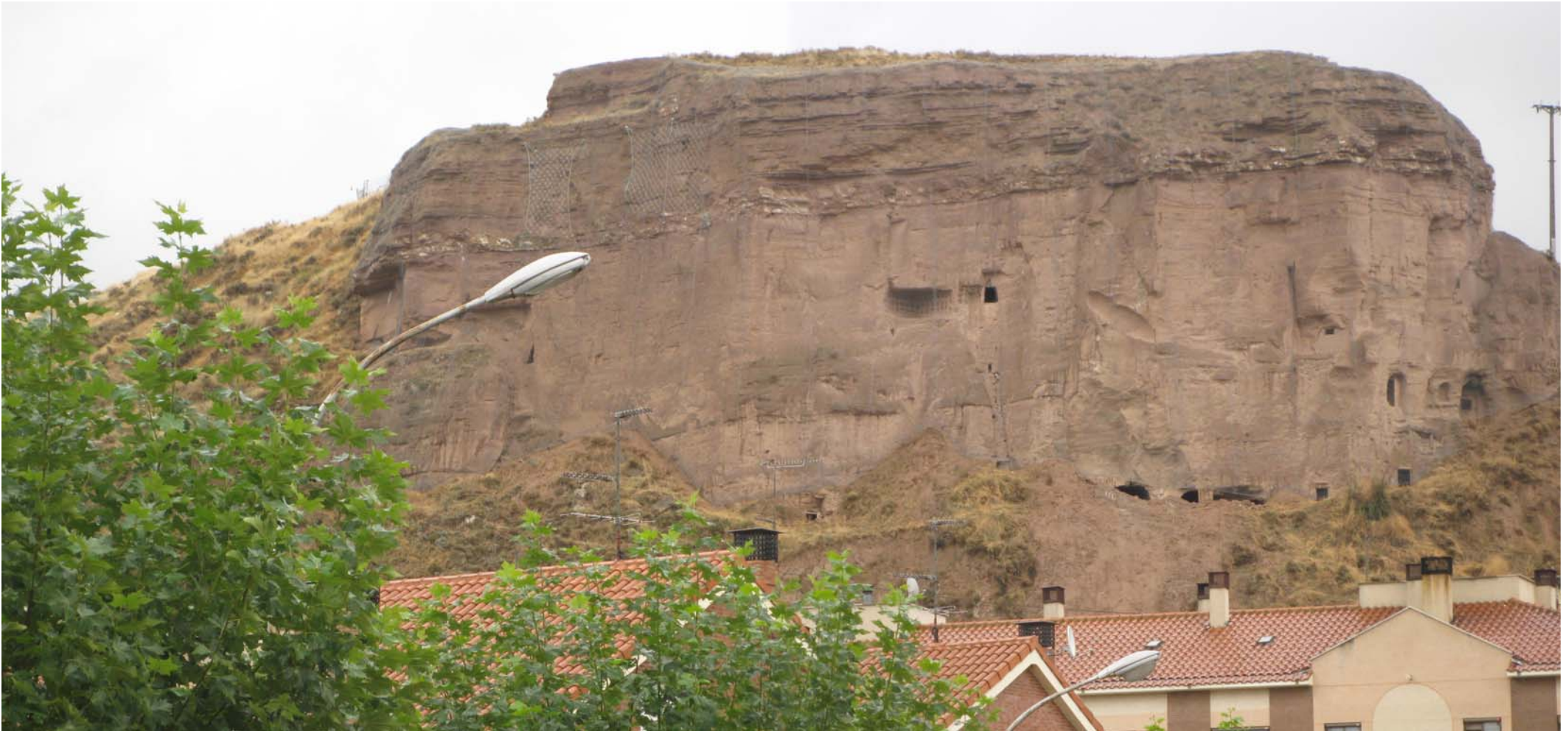
Vista general del talud, una vez acabados los trabajos de estabilización
