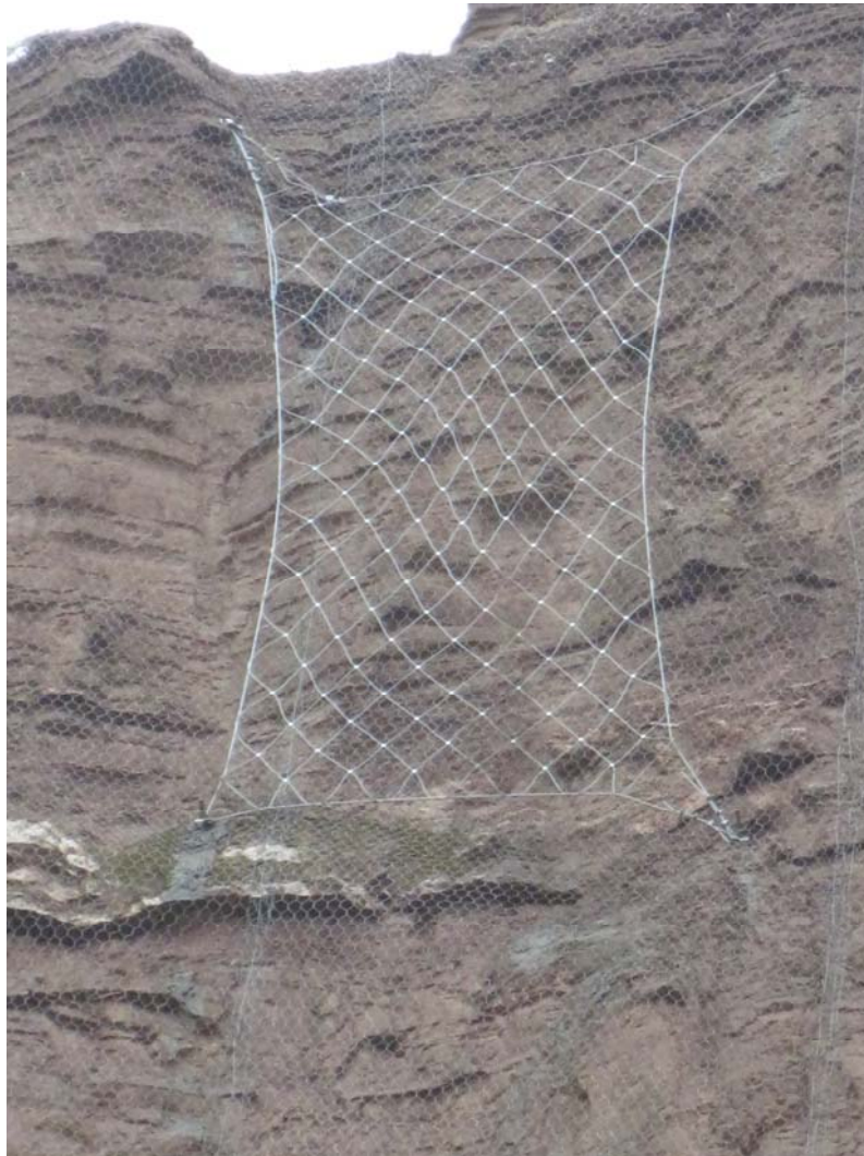
Destalle de las dos zonas reforzadas con red cable de acero
