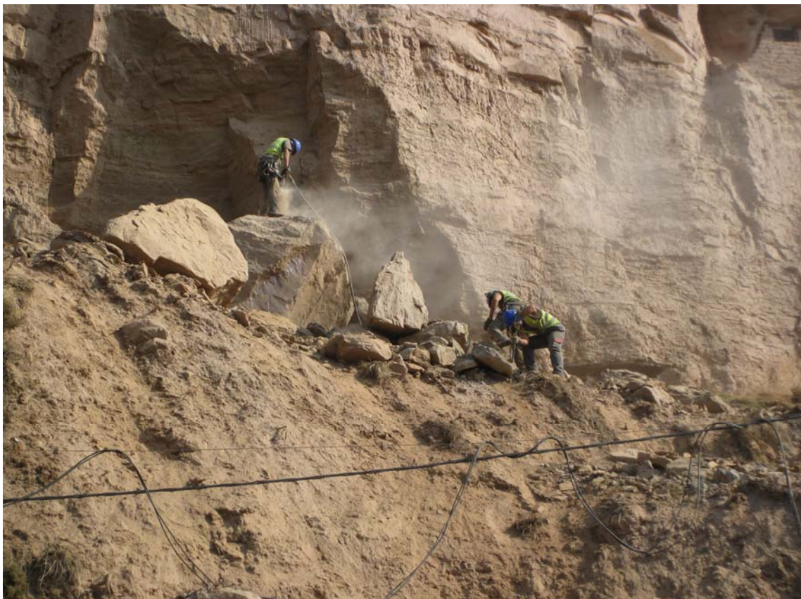
Trabajos de perforación de bloques para su rotura con mortero expansivo
