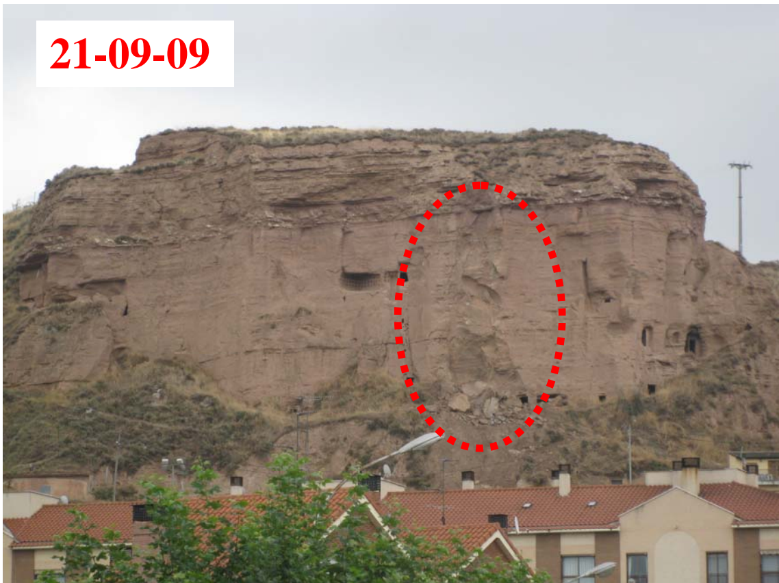
Vista frontal del talud, días antes y después del desprendimiento de la columna rocosa
