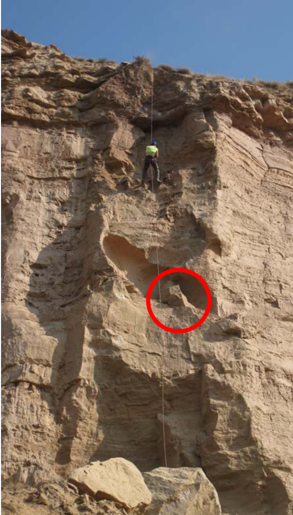
Trabajos de saneo manual de la superficie del talud, mediante la utilización de “patas de cabra”. En la secuencia fotográfica se observa la eliminación de un bloque de aprox. 0,5 m3.
