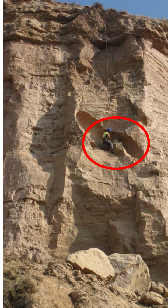
Trabajos de saneo manual de la superficie del talud, mediante la utilización de “patas de cabra”. En la secuencia fotográfica se observa la eliminación de un bloque de aprox. 0,5 m3.
