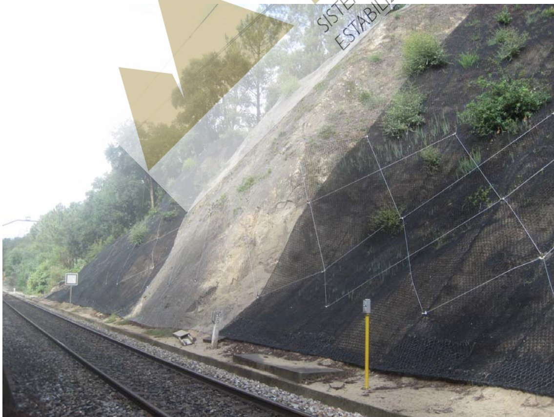
SECTOR 1 Y 2 Vista parcial de la trinchera, previa y posterior a los trabajos de estabilización mediante geomalla y malla de triple torsión reforzada
