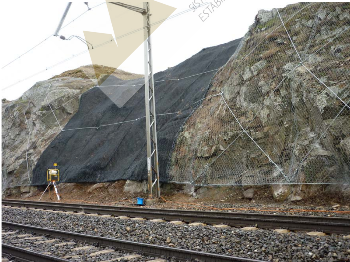
Vista parcial de la trinchera, previa y durante los trabajos de colocación de malla de triple torsión y malla Bianmat
