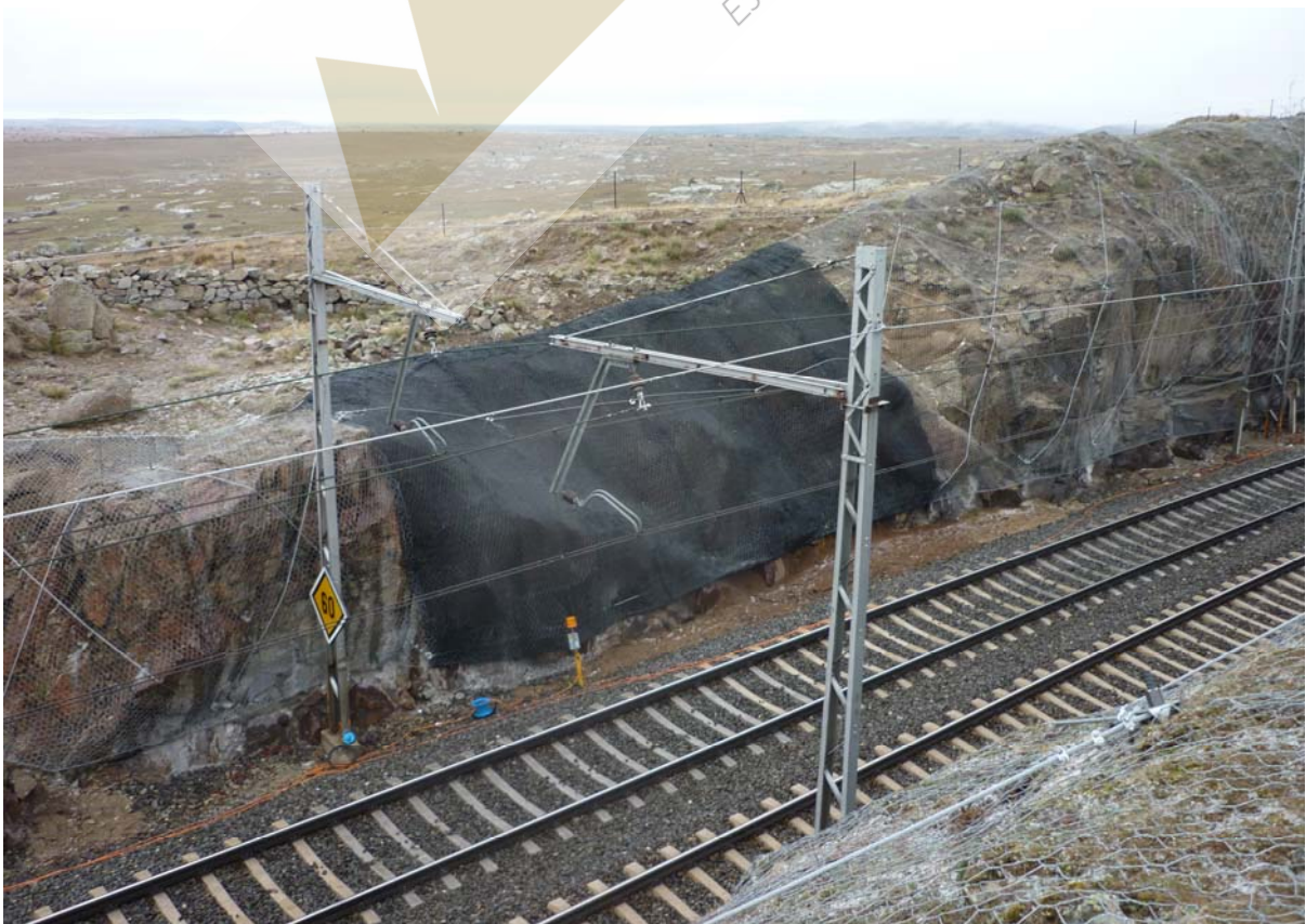
Detalle del anclaje de la malla en cabecera de talud. Vista de una zona del talud estabilizado mediante malla tipo Bianmat
