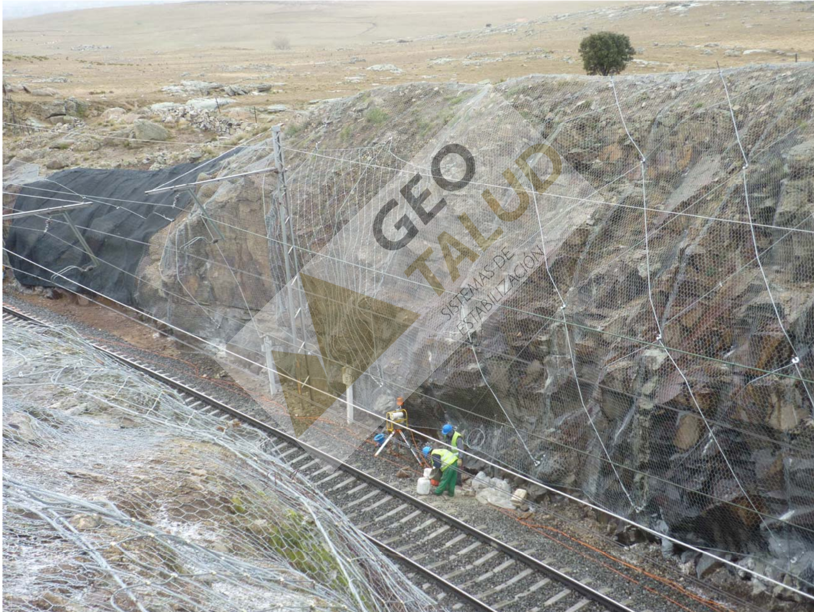
Vista parcial de uno de los taludes, donde se aprecian las diferentes técnicas de estabilización
