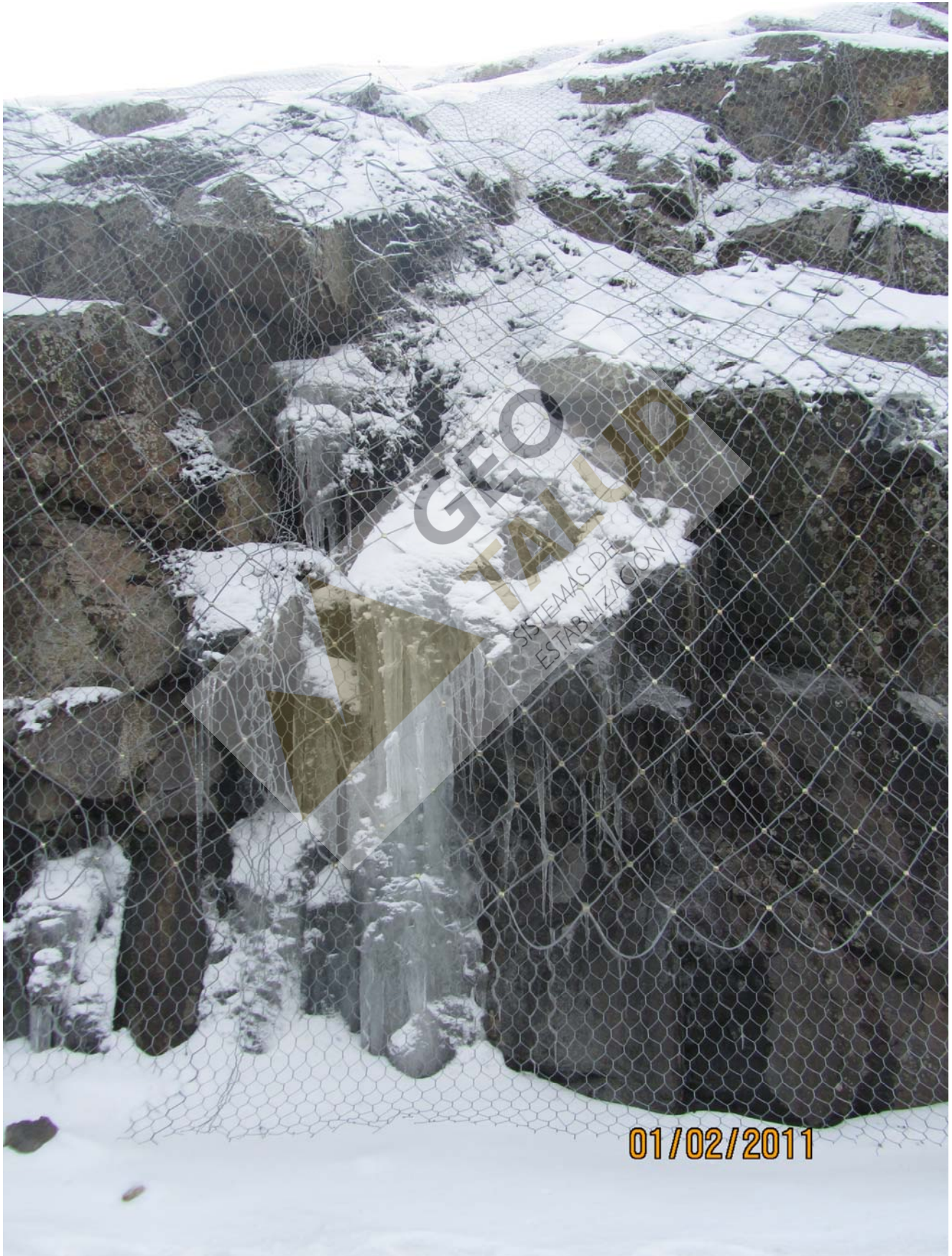
Vista parcial de uno de los taludes durante los trabajos de estabilización
