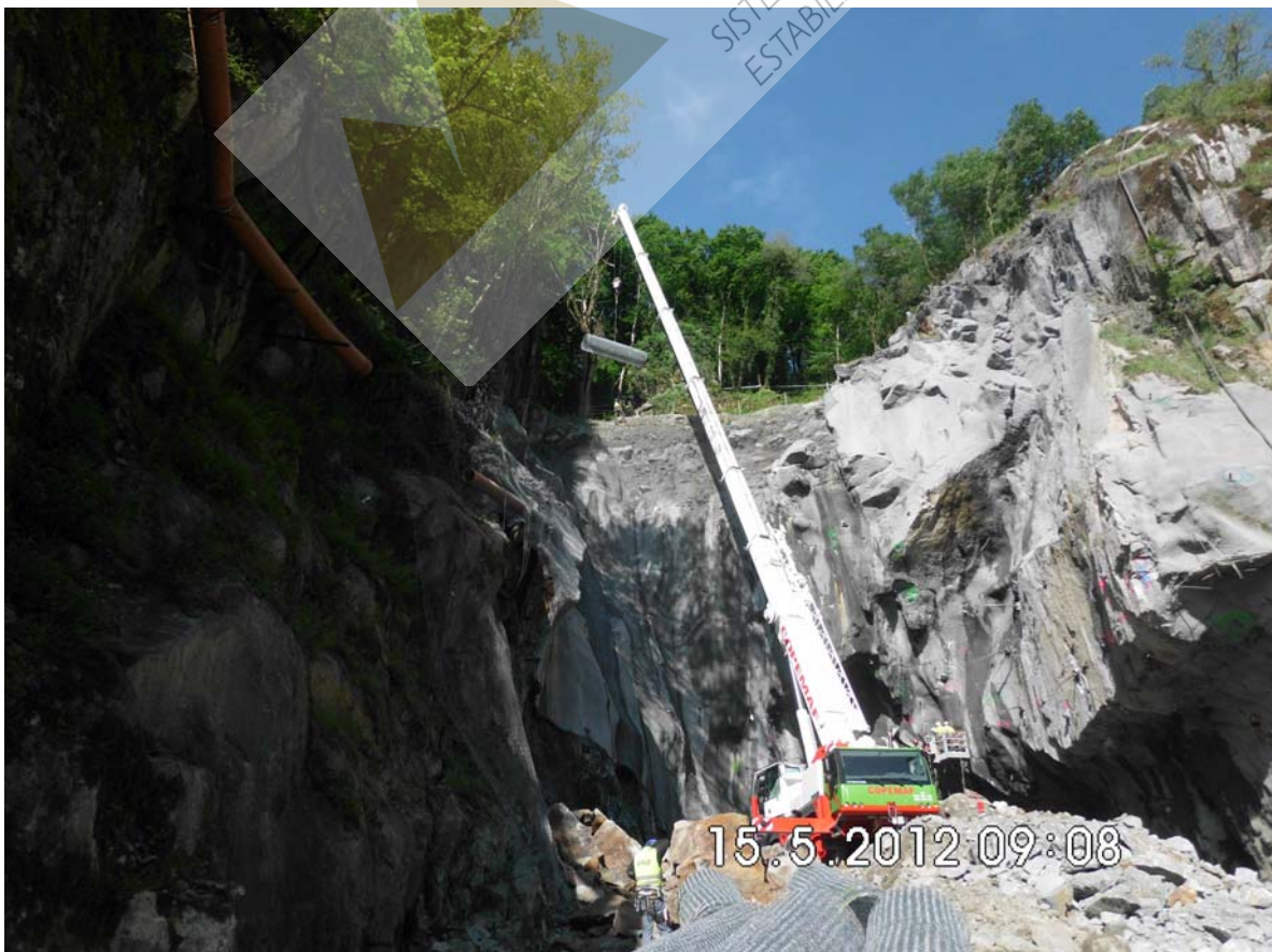
Posicionamiento de malla de triple torsión y red de anillos en cabecera de talud mediante grúa autopropulsada
