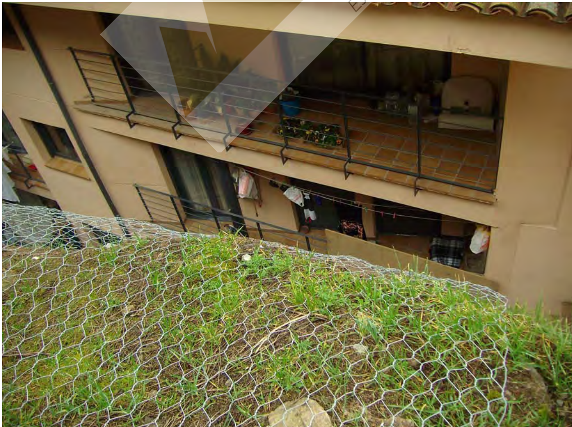
Vista del talud y detalle de los trabajos de extendido de paños de malla de triple torsión y red de cable de acero
