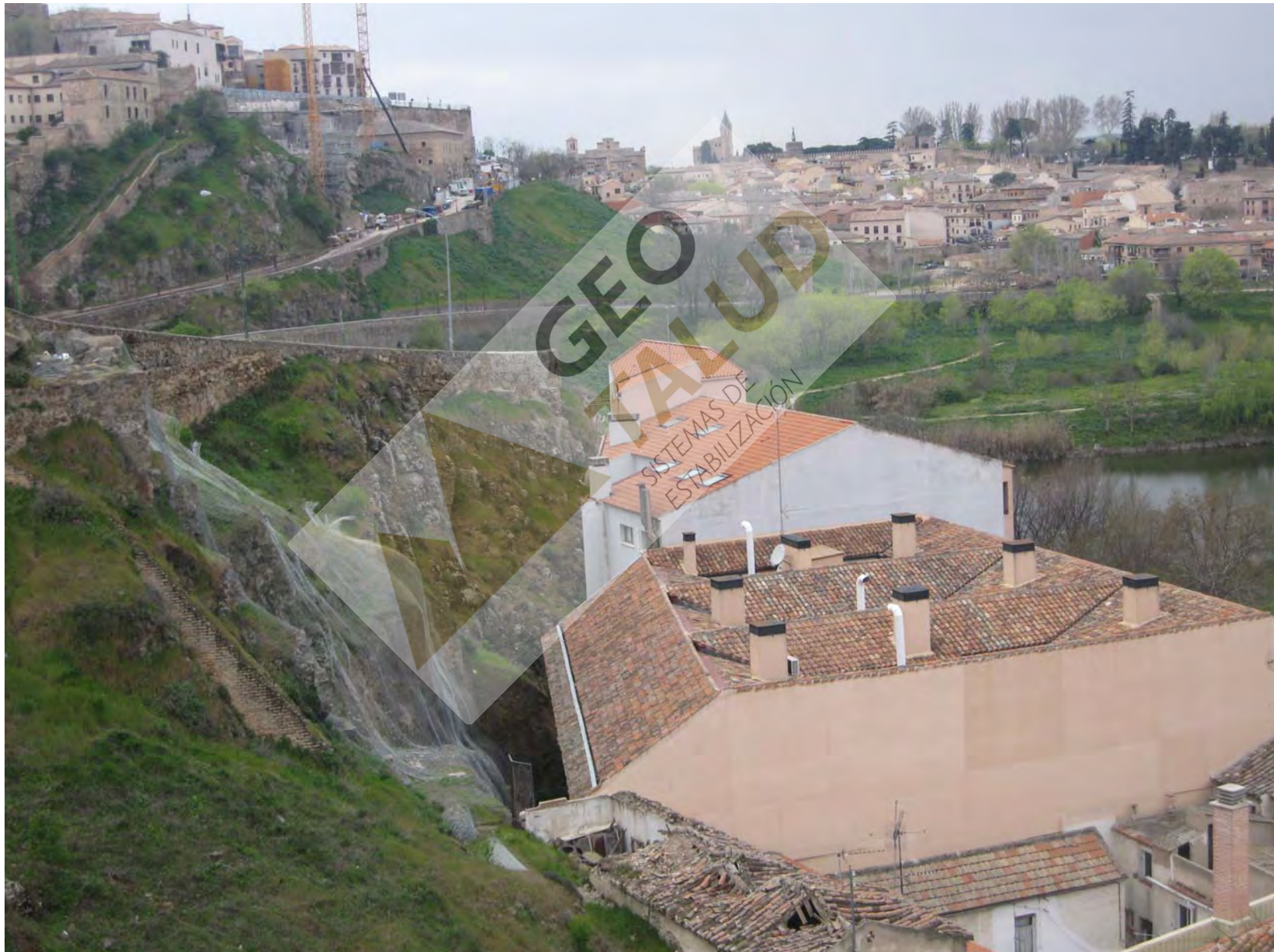
Vista general del talud durante los trabajos de estabilización
