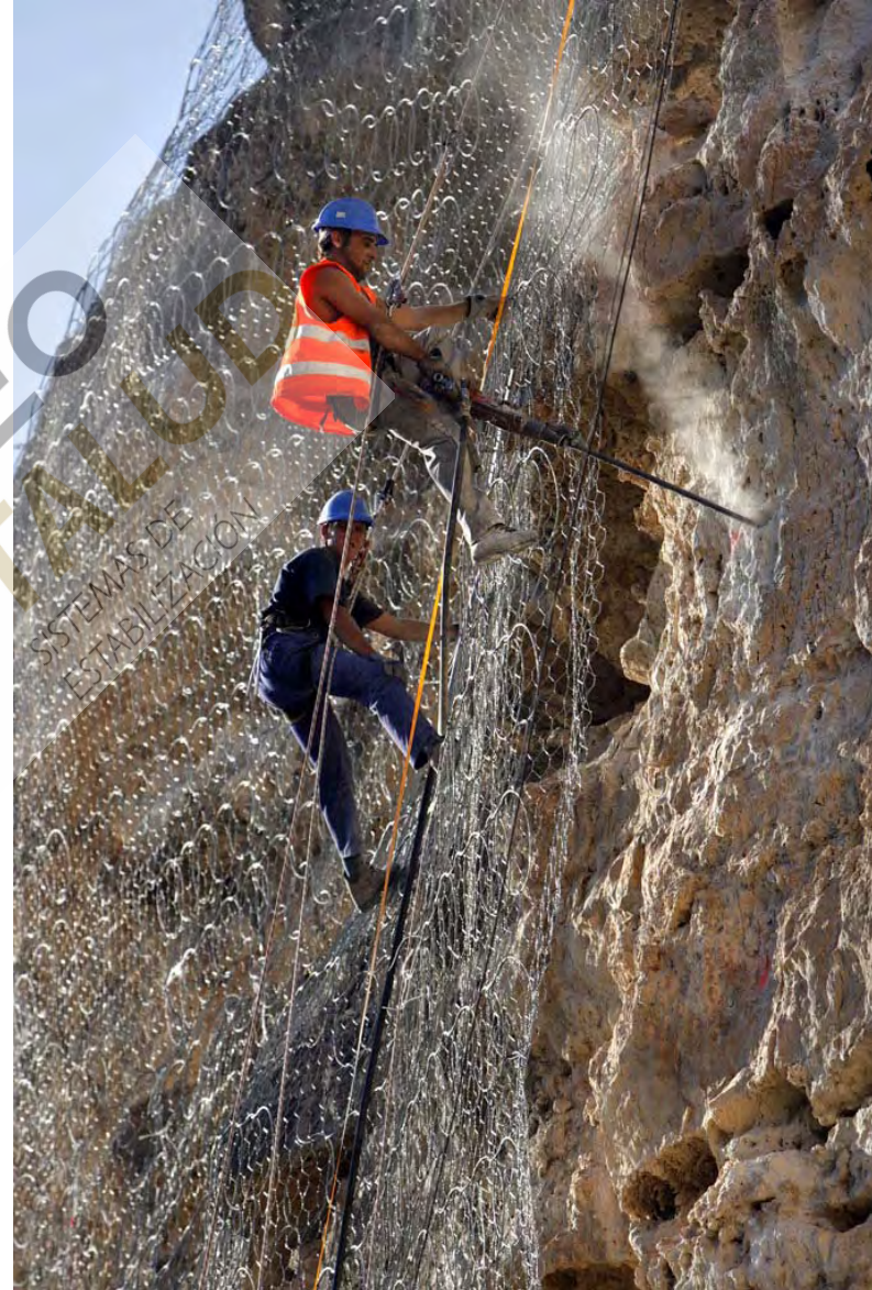
Trabajos de perforación en la red de aros de acero
