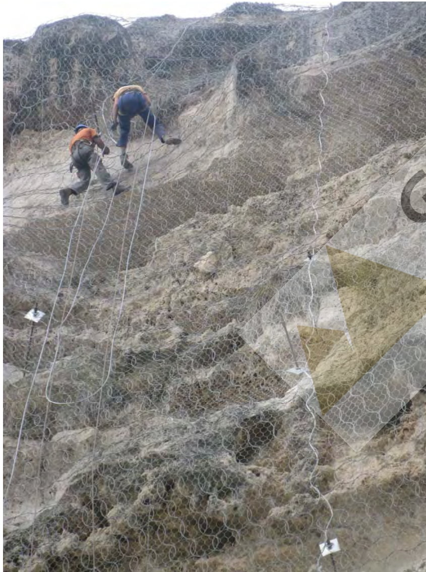
Detalle de trabajos de colocación de la red de anillos
