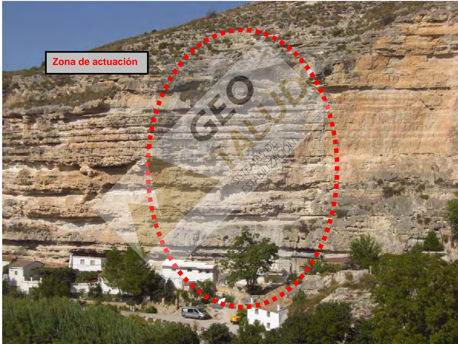
Vista general del talud estabilizado con red de aros de acero
