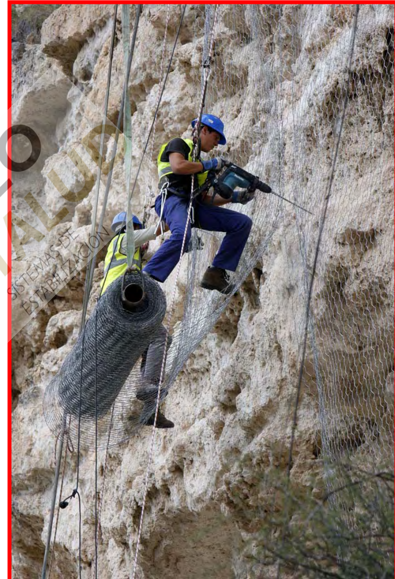
Detalle de trabajos de colocación de la malla de triple torsión
