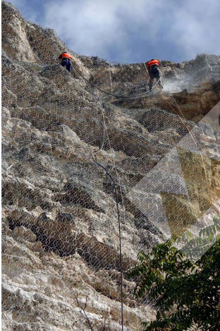
Trabajos de perforación en la red de aros de acero
