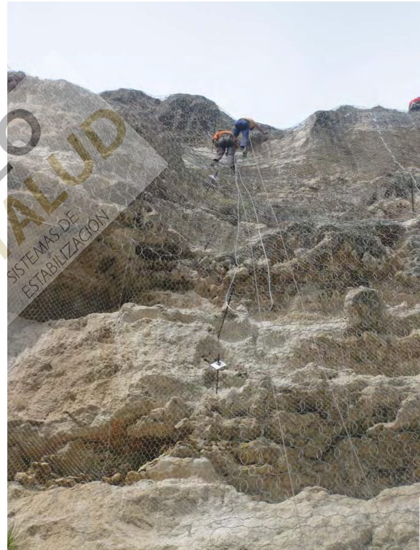
Detalle de trabajos de colocación de la red de anillos
