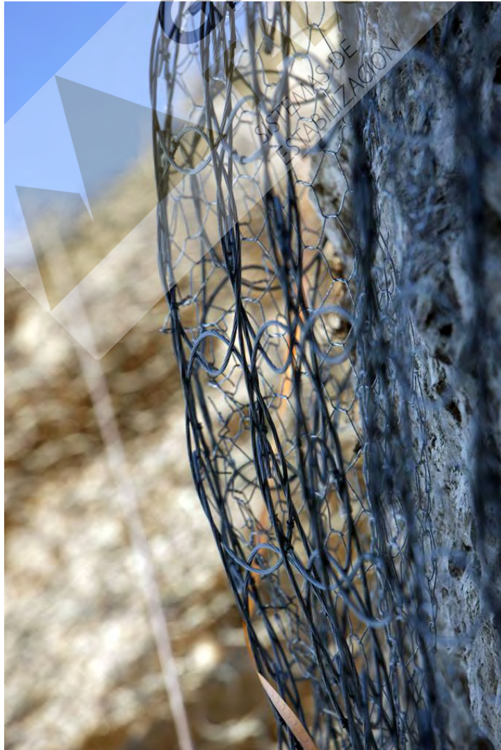
Detalle del talud una vez acabados los trabajos de estabilización
