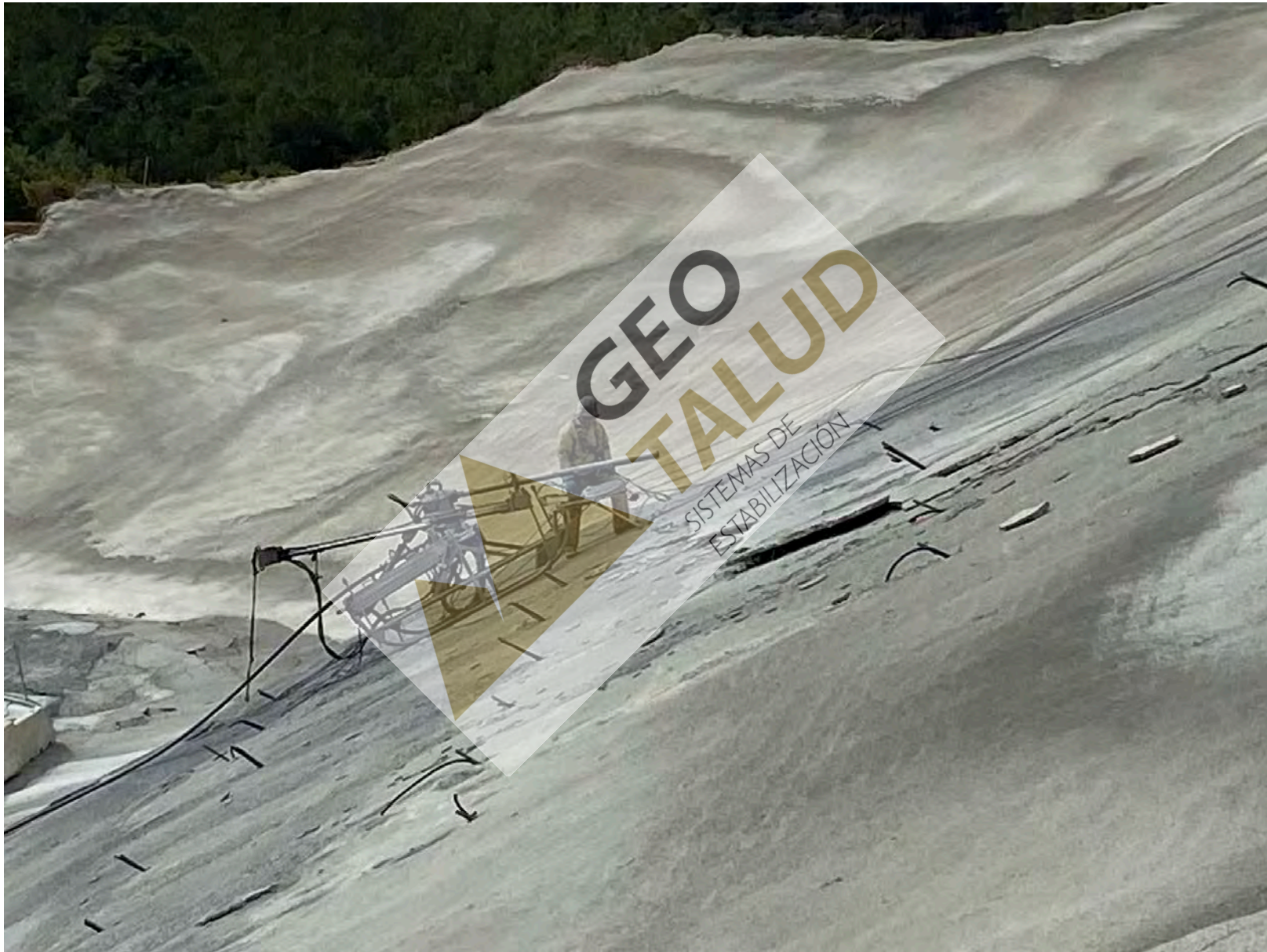
Detalle perforadora montada sobre patín (patín-perforador)
