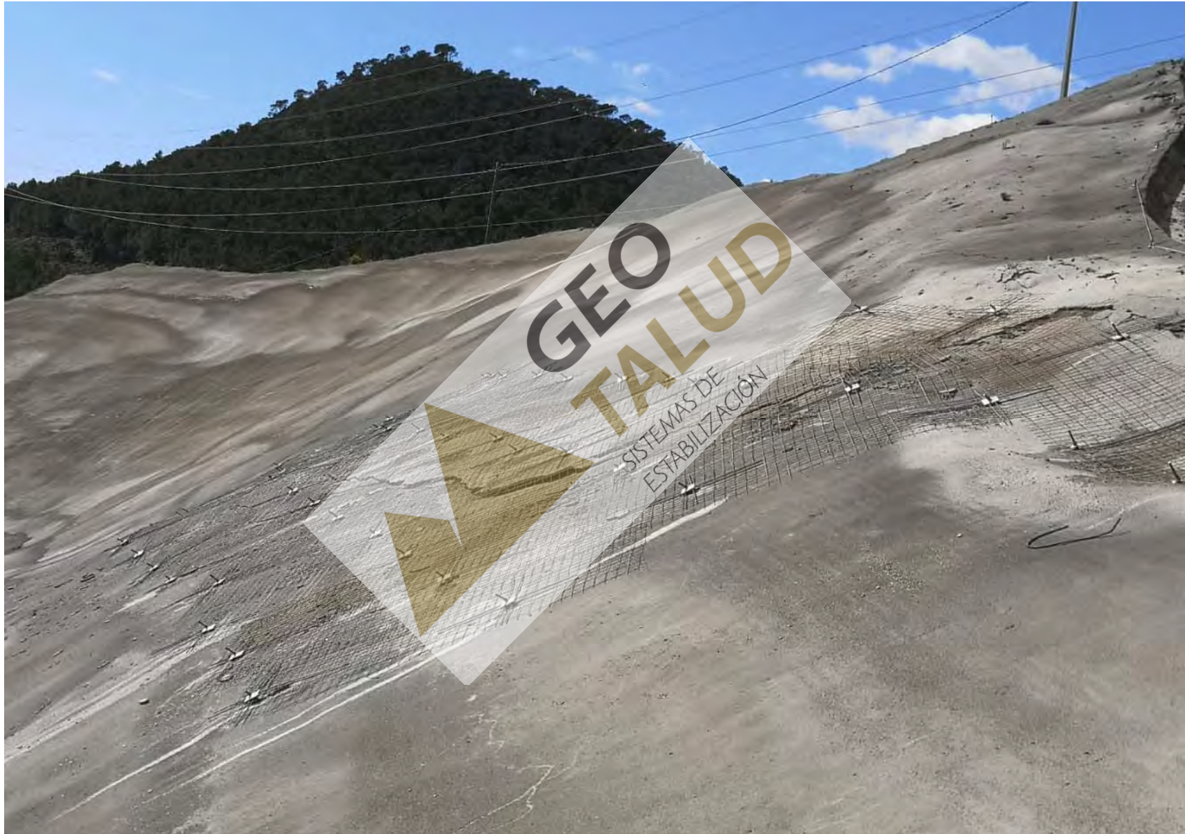
Detalle bulones y gunita
