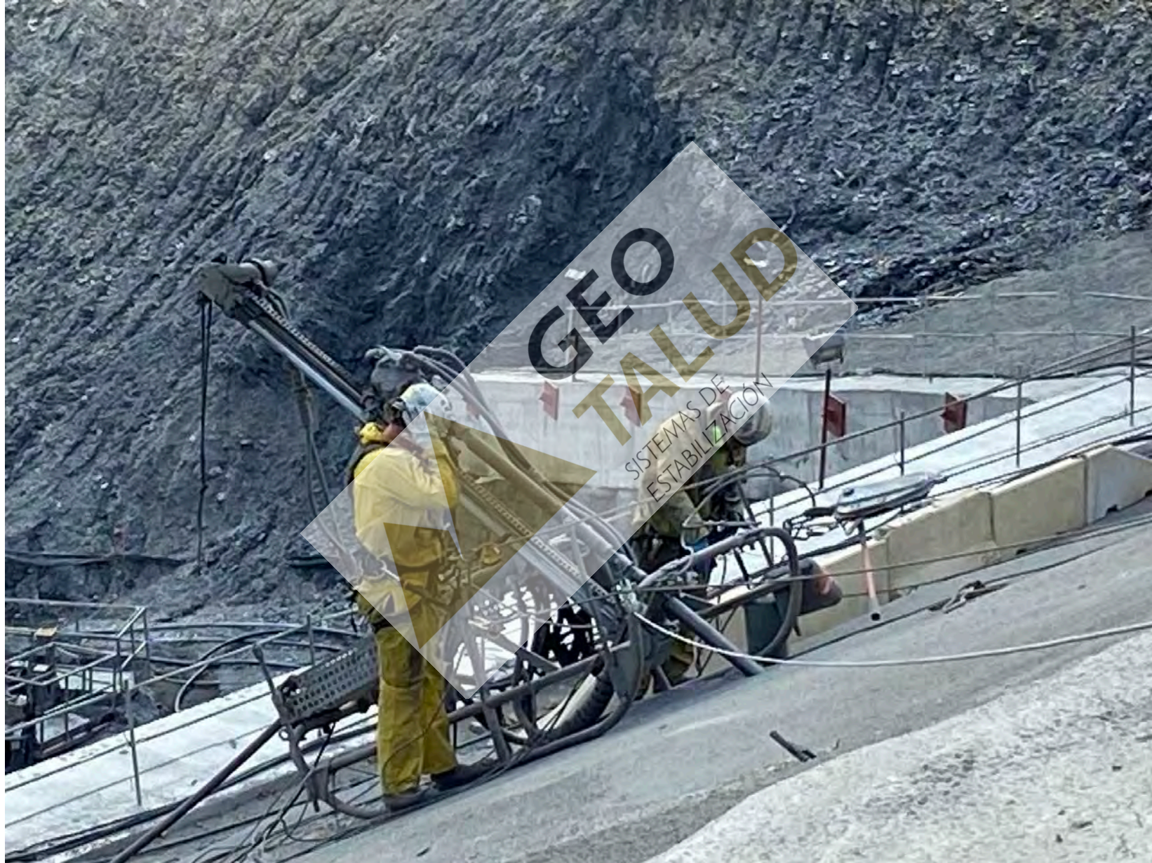
Detalle perforadora montada sobre patín (patín-perforador)
