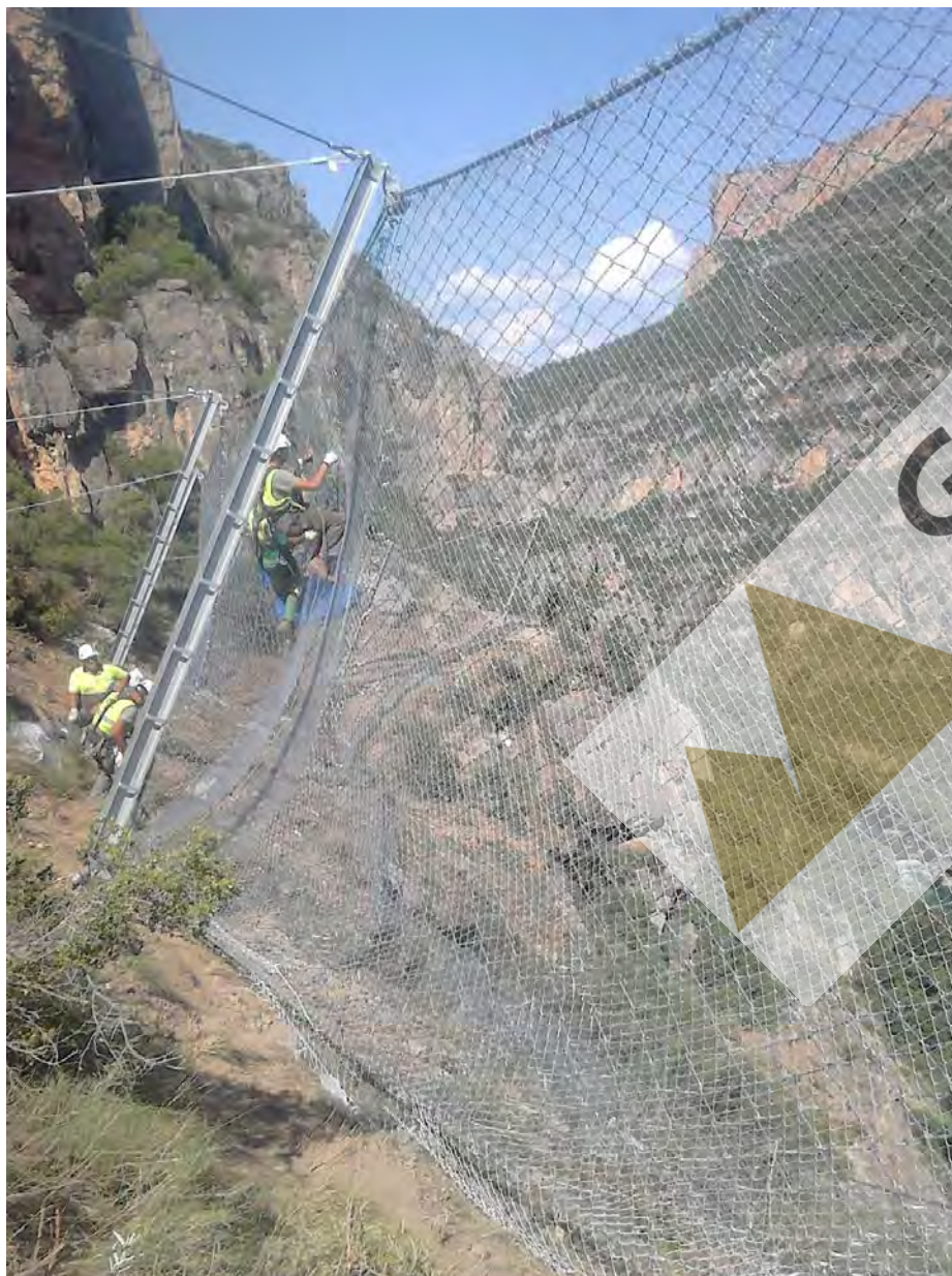
Trabajos de cosido de paños de red metálica
