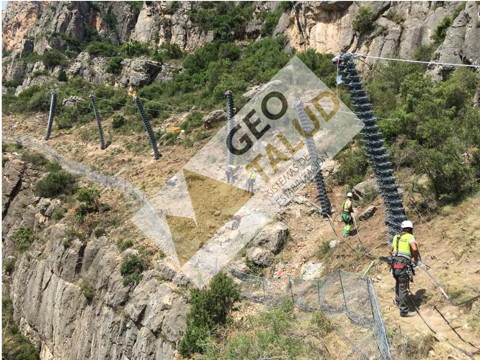
Trabajos de colocación de cables longitudinales
