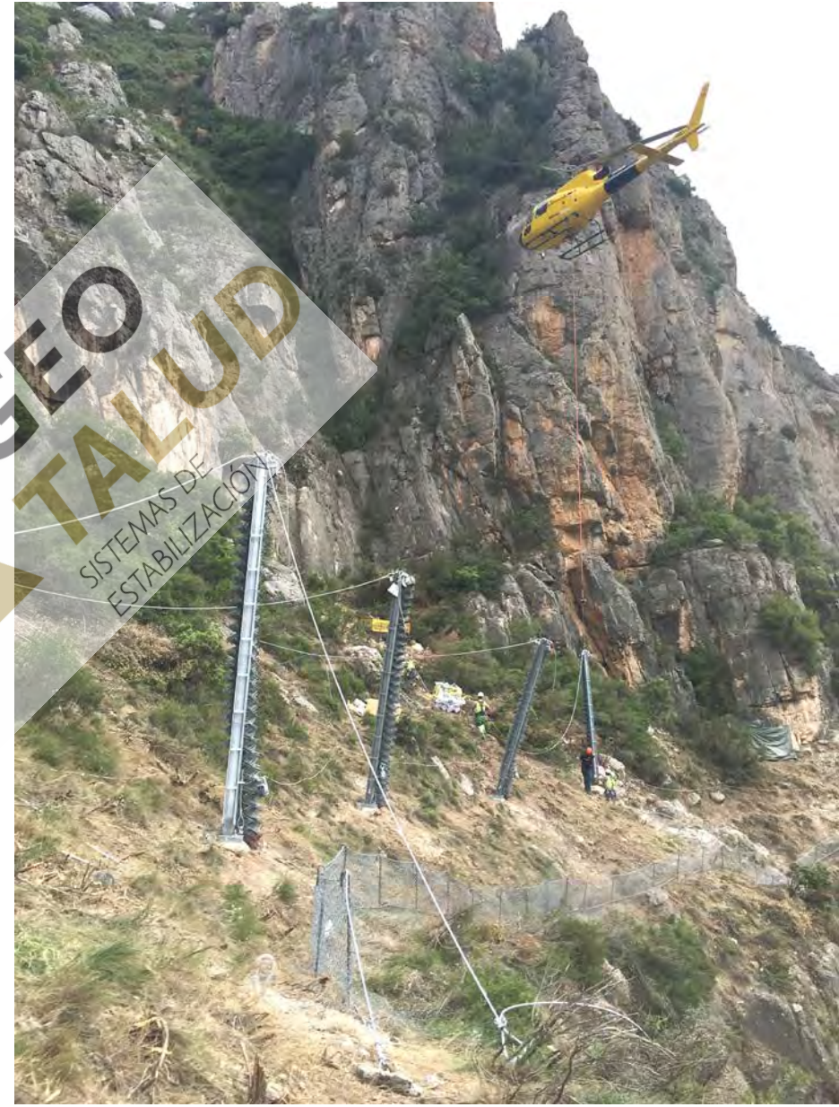
Transporte y colocación de postes y paños de red de acero
