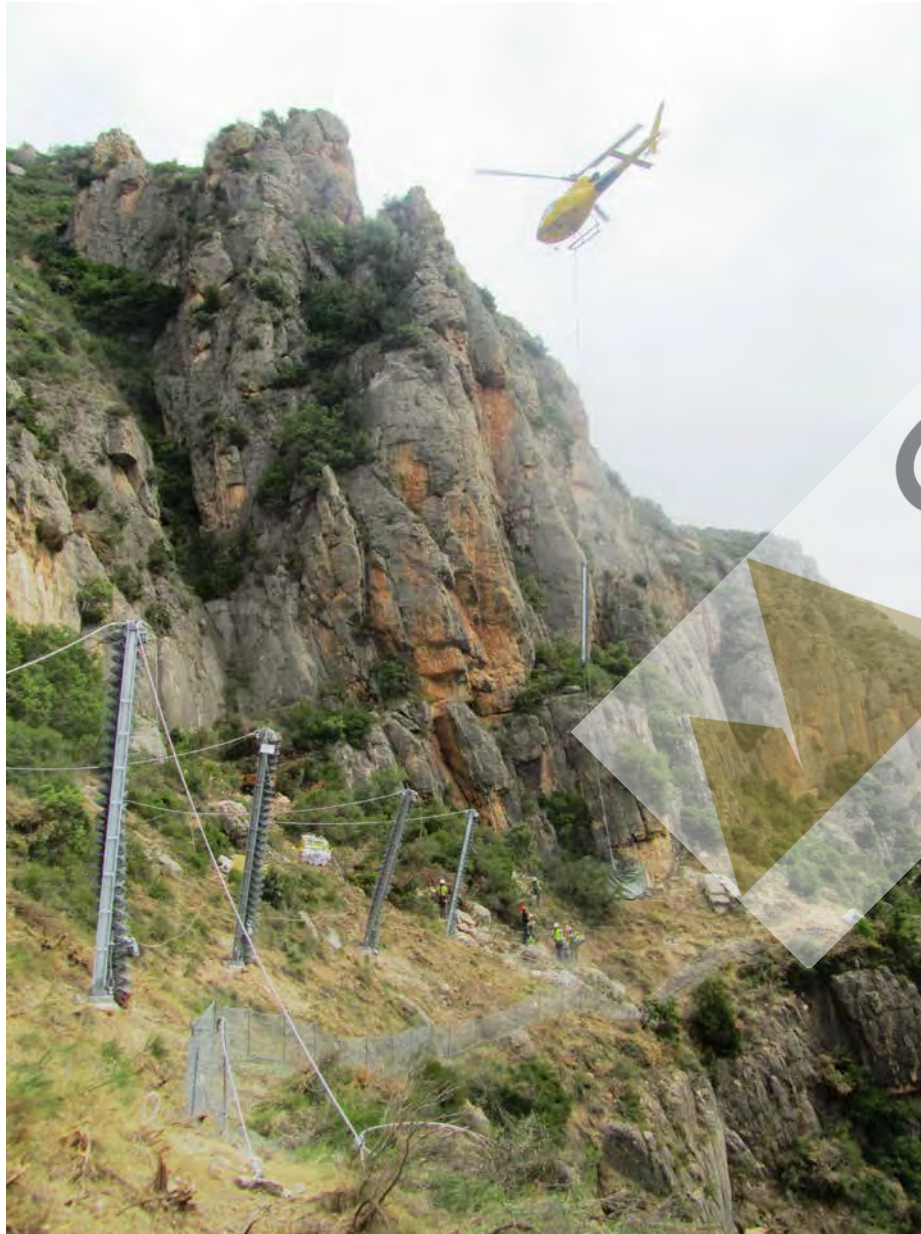
Transporte y colocación de postes y paños de red de acero
