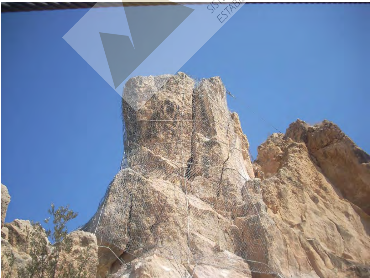
Vista parcial del cabezo, previa y posterior a su estabilización con red de anillos de acero
