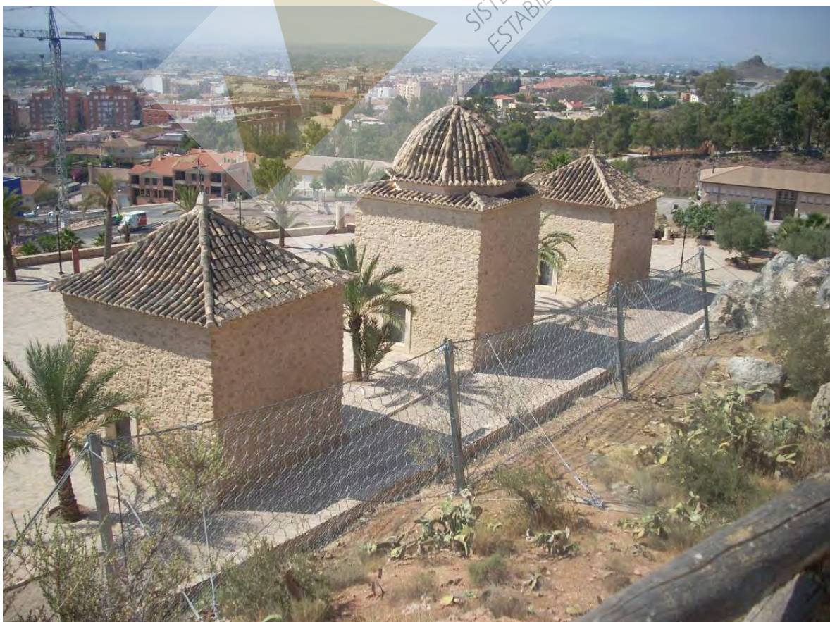
Vista general de las Ermitas del Calvario , previa y posterior a la colocación de la barrera dinámica
