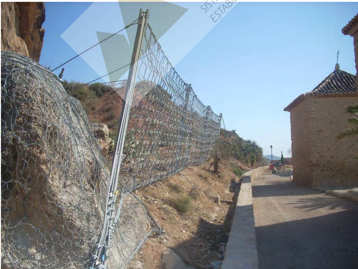
Vista parcial del cabezo, previa y posterior a su estabilización y a la colocación de la barrera dinámica .
