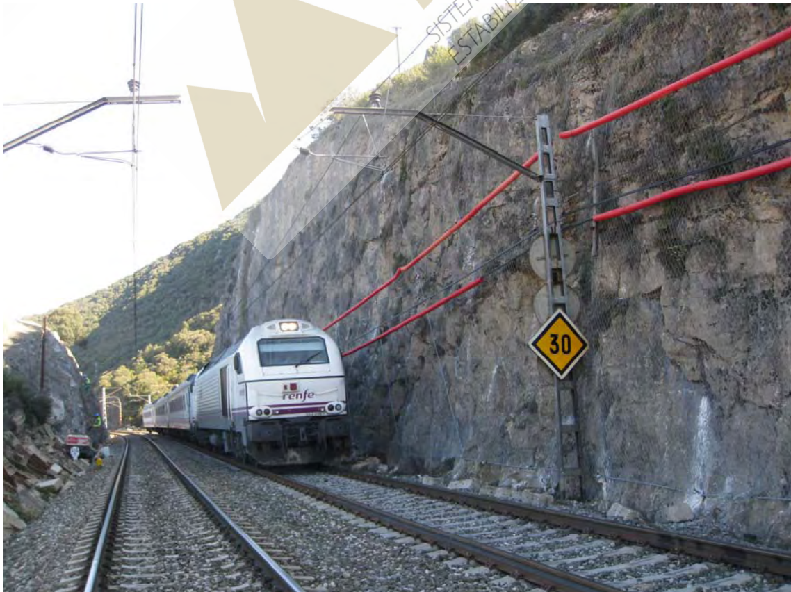
Detalle de talud estabilizado con malla de triple torsión
