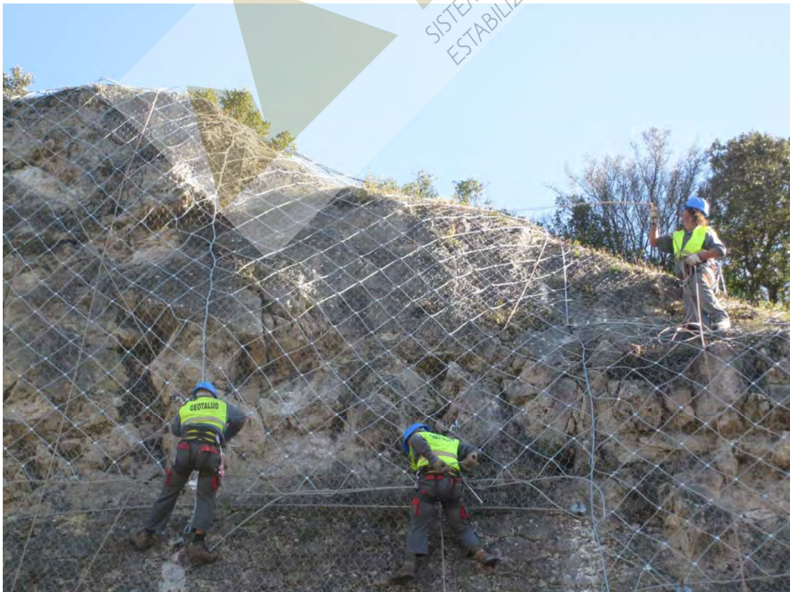
Detalle de los trabajos de bulonado y colocación de red de cable
