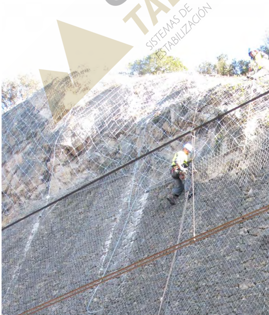
Detalle de los trabajos de izado de los paños de triple torsión
