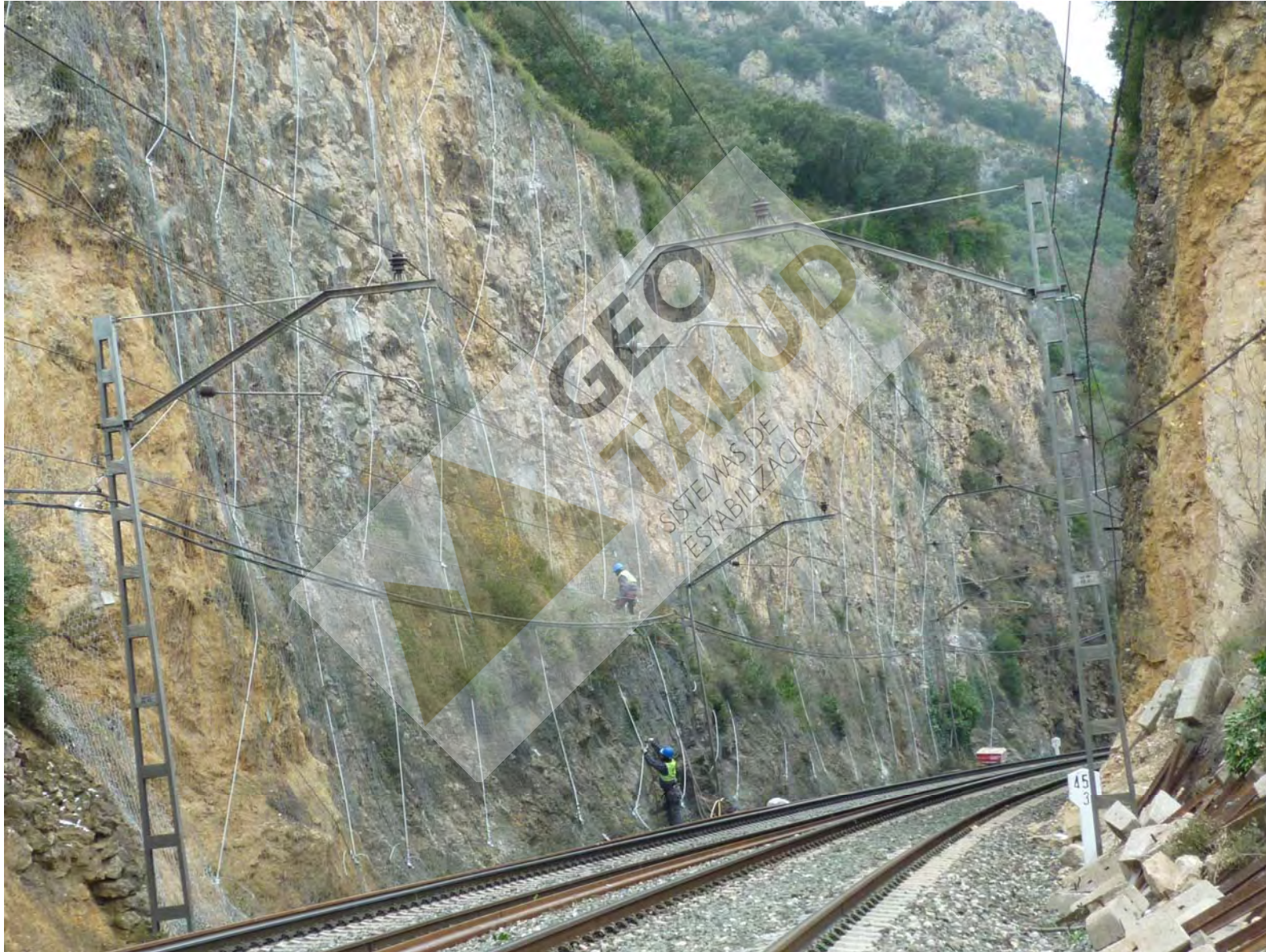
Detalle de uno de los taludes estabilizado con malla de triple torsión, reforzada con bulones y cuadrícula de cables
