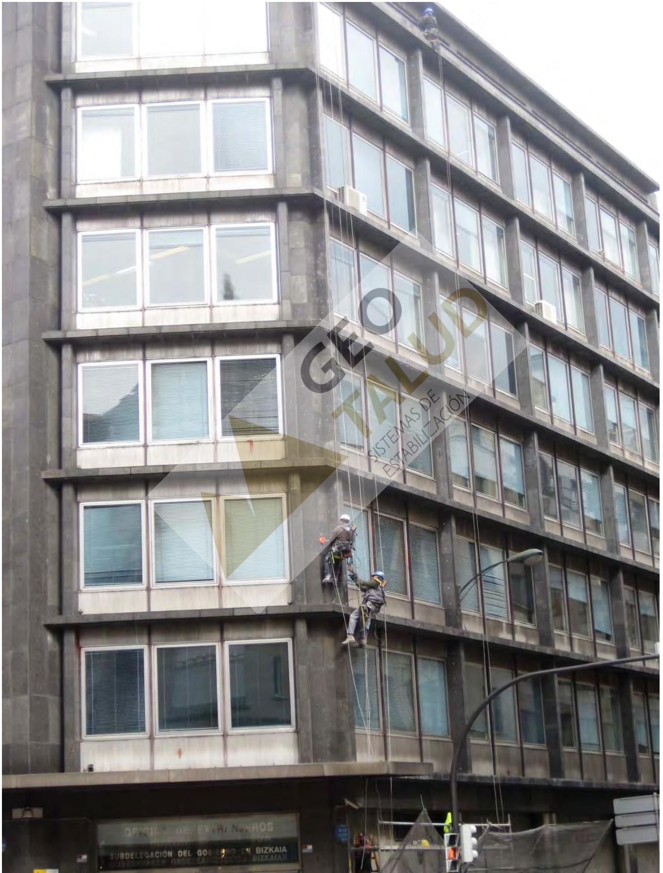
Vista de los operarios colgados desde la parte alta del edificio
