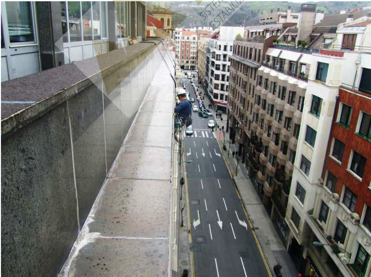
Detalle anclaje líneas de vida en terraza y de la cornisa por la que se inician los trabajos de descenso
