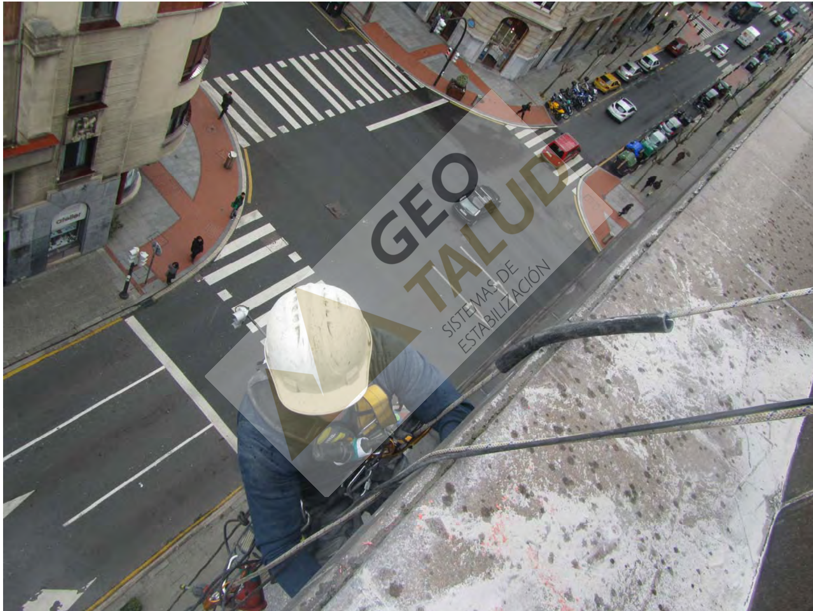
Detalle de cuerdas en cornisa superior y elementos de seguridad en arnés del operario
