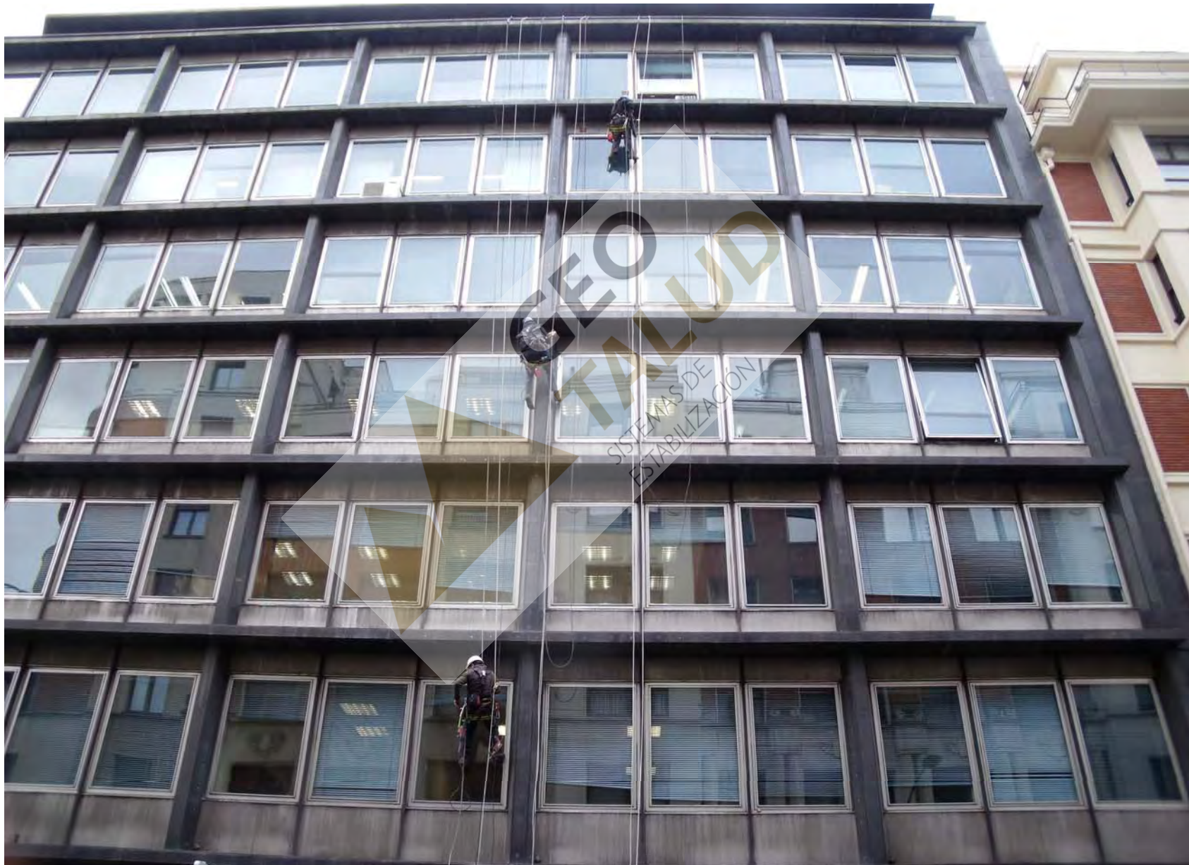
Vista de los operarios colgados desde la parte alta del edificio. Detalles fachada.
