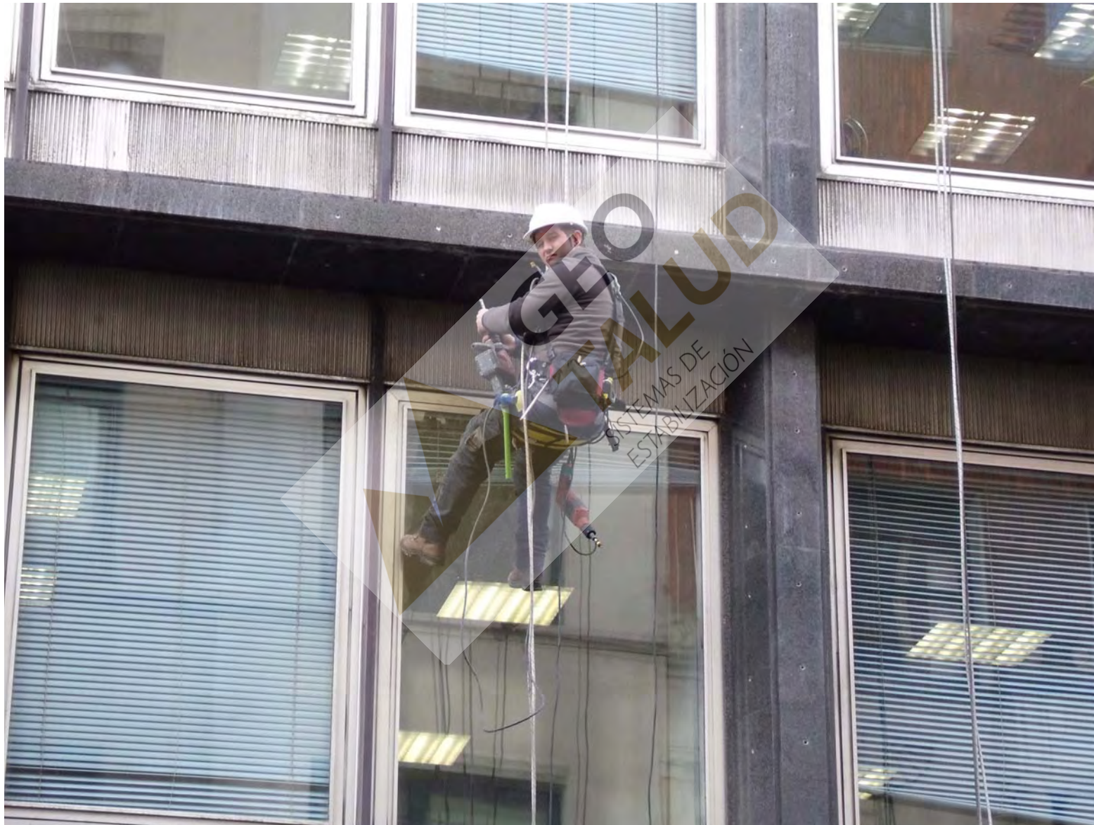
Detalle elementos de seguridad del operario
