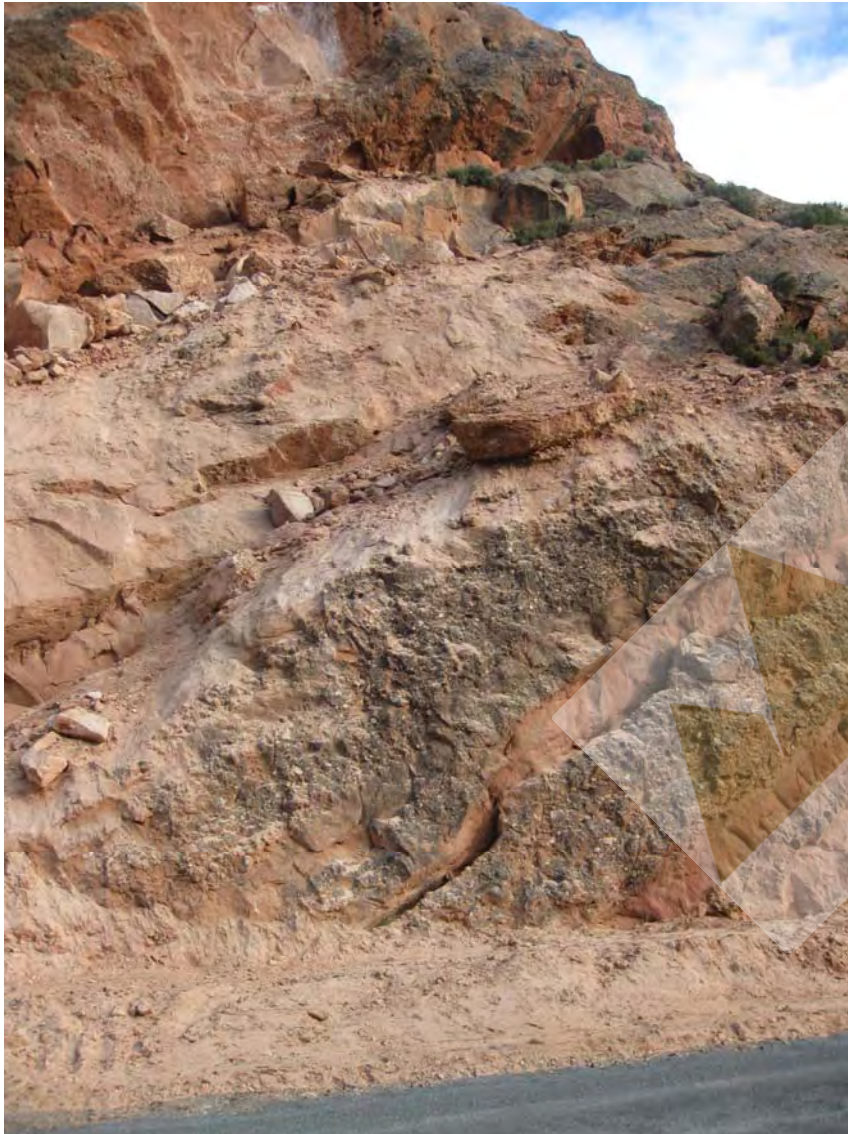
Detalle del saneo manual de bloques realizado
