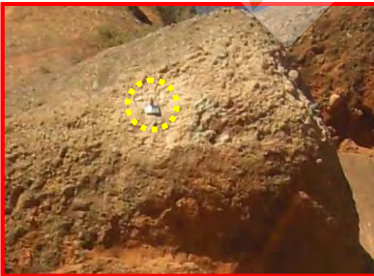
Detalle bloques bulonados (GEWI Ø32 mm. L= 6 m.)
