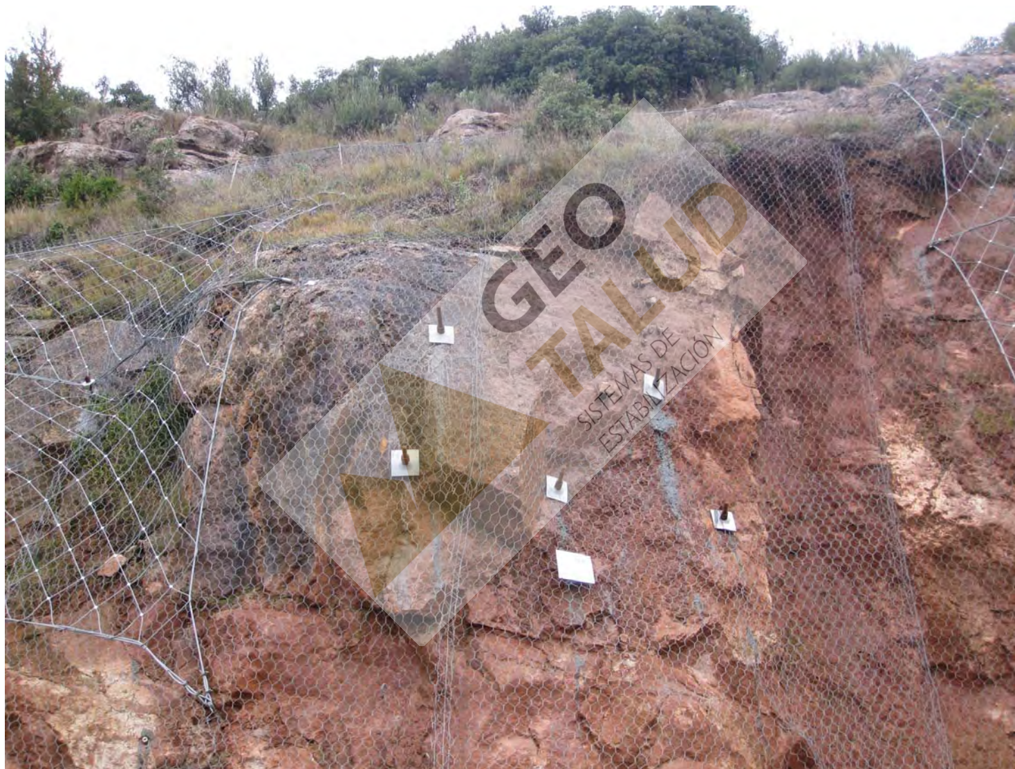
Detalle de bloque fijado con bulones de acero GEWI Ø 32 mm L = 6 m.
