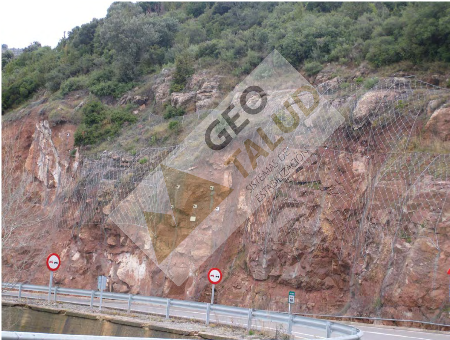
Vista general del talud estabilizado mediante red de cable de acero y bulones GEWI
