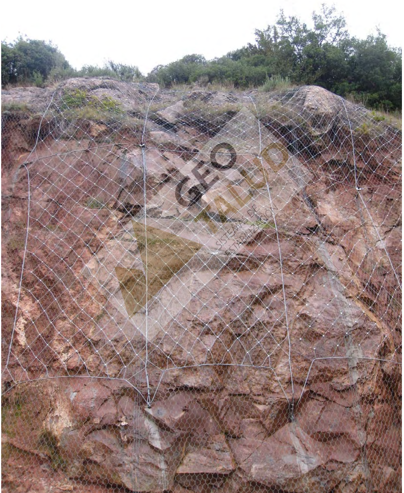
Vista Detalle de los paños de red de cable colocados sobre la malla de triple torsión
