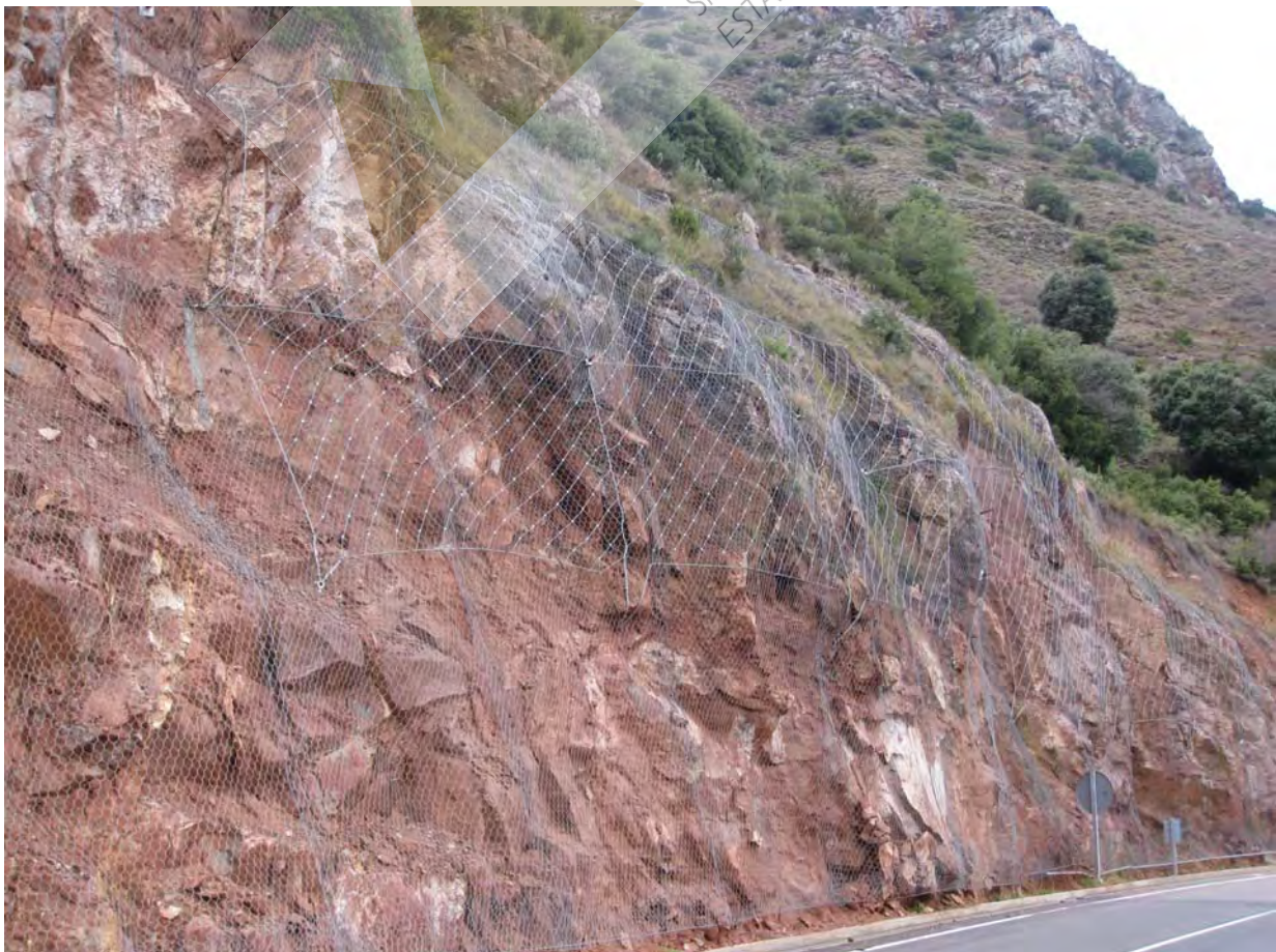
Vista de una zona del talud anterior y posterior a los trabajos de estabilización, mediante red de cable de acero y bulones
